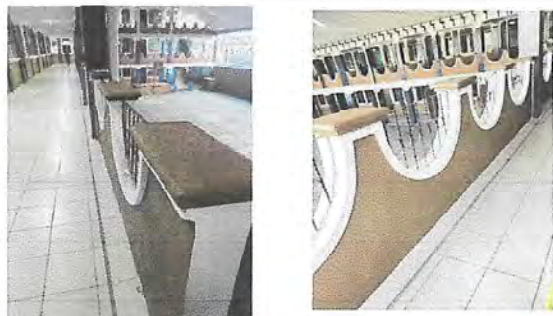
MODULO 9: reparación de repello y cernido de paredes; Suministro aplicación de repello más cernido en 58.00m2 de muro, así como el sellado de grietas con material sika en 29.00m2.
