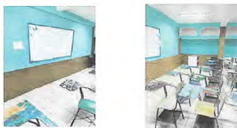
Foto 4: MODULO 4: PINTURA EN MUROS EXTERIORES E INTERIORES SUMINISTRO Y APLICACIÓN DE DOS MAOS DE PINTURA ACRILICA, ACABADO MATE, ANTI HONGOS.
