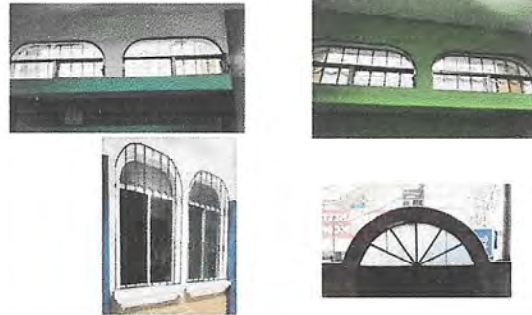
Foto 2: MODULO 2 VENTANAS: Mantenimiento de marcos de ventanas de aluminio mil finisish, limpieza e instalación de vidiros faltantes.
