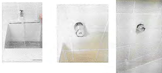
Foto 5: MODULO 5/SERVICIOS SANITARIOS Y SUS ACCESORIOS: sustitución suministro e instalación de llaves de paso de 1/2 sustitución suministro e instalacion de grifos 172
