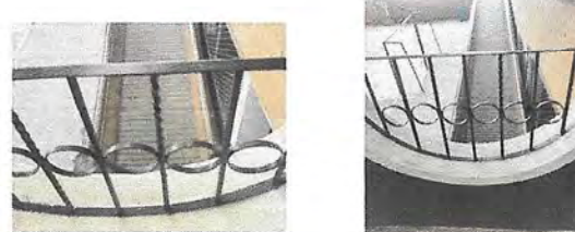
Foto 6: MODULO 6 MANTENIMIENTO DE BARANDAS: Reparación y mantenimiento de 17.00m2 de barandal de metal
