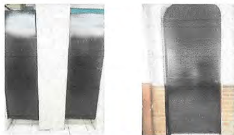
Foto1: MODULO 1 PUERTAS : Mantrenimiento de estructura (lijado, cambio de tubo, cepillado, aplicación de pintura)
