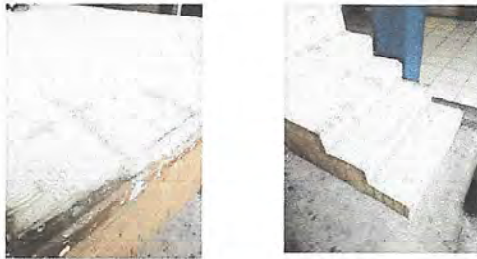
Foto 3: MODULO 3 PISO: Sustitución suministro de piso cerámico
