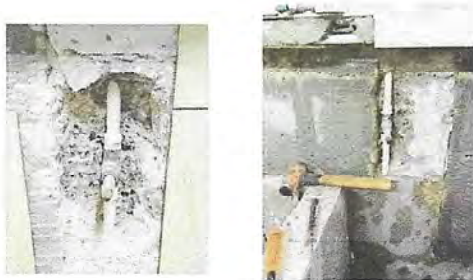
Foto 5: MODULO 5/SERVICIOS SANITARIOS Y SUS ACCESORIOS: sustitución suministro e instalación de llaves de paso de 1/2 sustitución suministro e instalacion de grifos 172
