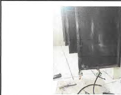
Foto 1: MODULO 1 PUERTAS : Mantrenimiento de estructura (lijado, cambio de tubo, cepillado, aplicación de pintura)
