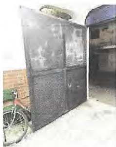
MODULO 7/MANTENIMIENTO A PORTONES, Reparación y mantenimiento de porton de metal, lijado dos manos de pintura anticorrosiva y sustitución de piezas en mal estado, rectificación de
