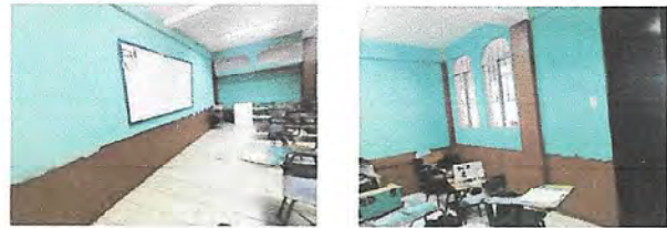
Foto 4: MODULO 4: PINTURA EN MUROS EXTERIORES E INTERIORES SUMINISTRO Y APLICACIÓN DE DOS MAOS DE PINTURA ACRILICA, ACABADO MATE, ANTI HONGOS.
