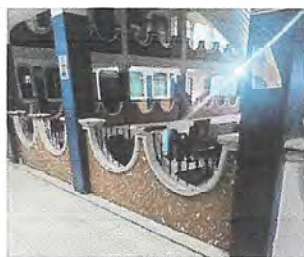
MODURO 9: reparación de repello y cernido de paredes; Suministro aplicación de repello más cernido en 58.00m2 de muro, así como el sellado de grietas con material sika en 29.00m2.
