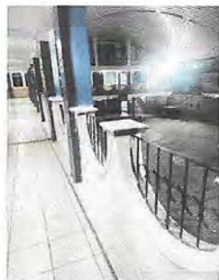
MODURO 9: reparación de repello y cernido de paredes; Suministro aplicación de repello más cernido en 58.00m2 de muro, así como el sellado de grietas con material sika en 29.00m2.
