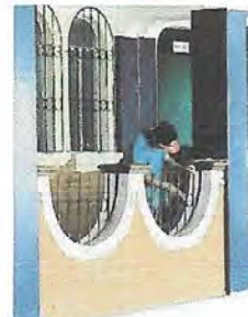
Foto 6: MODULO 6 MANTENIMIENTO DE BARANDAS: Reparación y mantenimiento de 17.00m2 de barandal de metal
