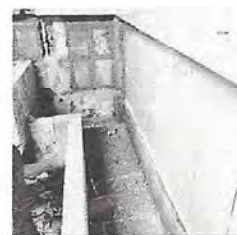
MODULO 8 REPARACIÓN O SUSTITUCION DE AZULEJO: Sustitución, suministro e instalación de azulejo en área de minigitorio de area de pila de baño de varones.
