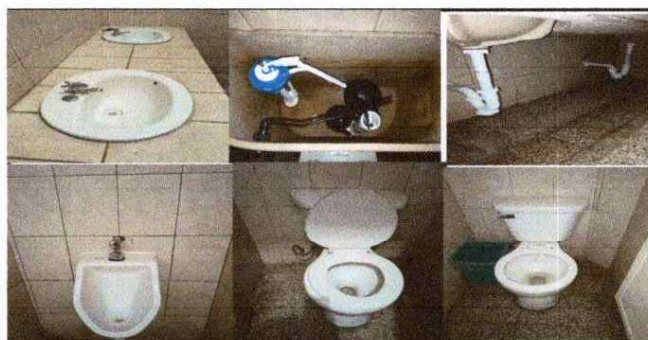
Foto 6: Limpieza de sistema de drenaje, remoción e instalación de sistema de paso (llave) e instalación hídrica en 8 lavamanos, en los servicios sanitarios y remoción, compra e instalación de 2 migitorio en los
