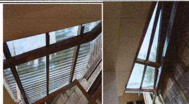
Foto1: Techado en área de pilas con lámina de policarbonato.
