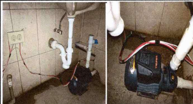
Foto7: instalación de sistema hídrico y eléctrico, de una bomba de un caballo de fuerza.
