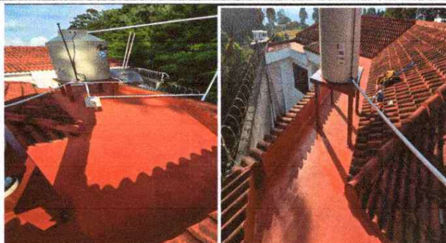
Foto 2: Limpieza e impermeabilización de terrazas, de gradas de comunicación y segunda planta.
