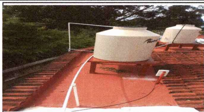
Foto 8: colocación de dos tinacos de 1100 litros e instalación hídrica y de regulación de líquidos.
