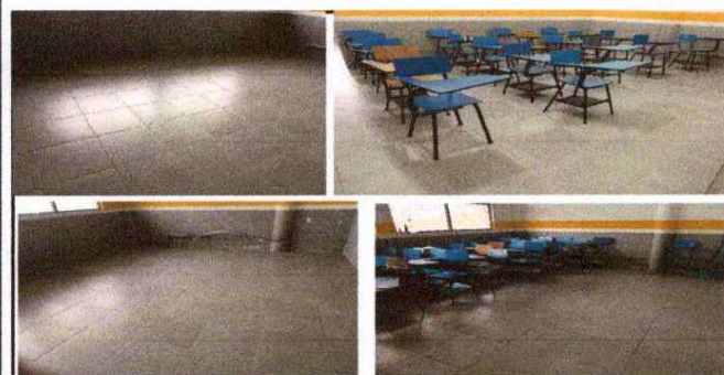
Foto 5: Interrupción de la corriente eléctrica, relleno de los agujeros donde hay tomacorrientes en el suelo y colocación de piso cerámico en los salones de cuarto primaria sección "A" y "B".
