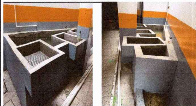
Foto 9: sustitución de pilas por una pileta con tres lavaderos.
