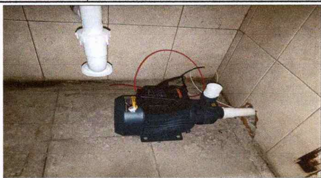
Foto 7: Compra, reemplazo e instalación de sistema hídrico y eléctrico, de una bomba de un caballo de fuerza.
