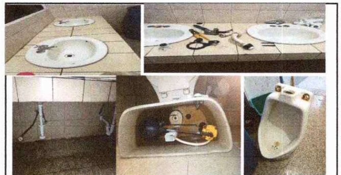
Foto 6: Limpieza de sistema de drenaje, remoción e instalación de sistema de paso (llave) e intalación hídrica en 8 lavamanos, en los servicios sanitarios y remoción, compra e instalación de 2 migitorio en los
