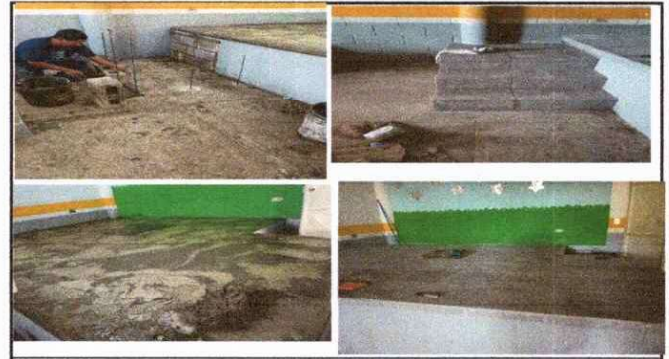
Foto 4: Colocación de piso antideslizante en el escenario del salón de usos múltiples de la escuela y construcción de gradas para acceso al escenario.
