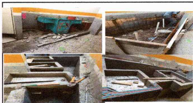
Foto 9: Remoción de dos pilas, limpieza de drenajes, reparación de cajas de drenaje y llave de paso. Fundición de pileta para el lavado de utensilios de limpieza.
