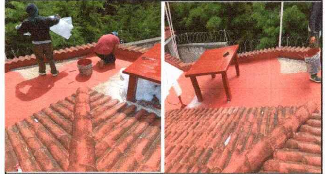
Foto 2: Limpieza e impermeabilización de terrazas, de gradas de comunicación y segunda planta.
