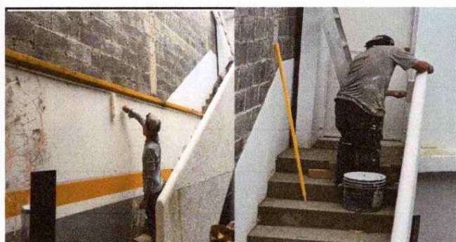
Pintura de muro: patio 1
