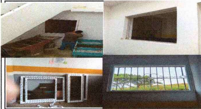
Foto 3: Retiro de ventanas de vidrio y paletas. Reemplazo por ventanas PVC, transparente y acústicas.
