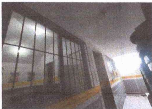
Foto1: Instalacion de ventanas ya instaladas
