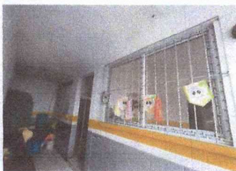
Foto 3: Aplicación de pintura pasillo a cocina
