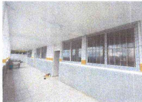
Foto 2: Instalacion de ventanas segundo nivel
