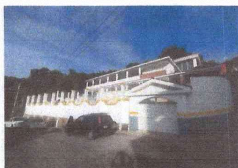
Foto 4: Aplicación Completa de pintura a toda el area exterior de la escuela
