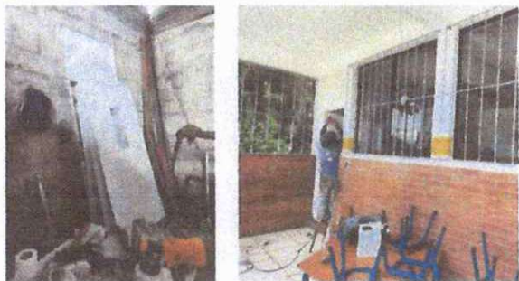
Foto1: puertas y remplazo de puertas de madera
