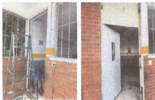
Foto 2: Instalacion de puertas nuevas de metal y soldadura de las mismas
