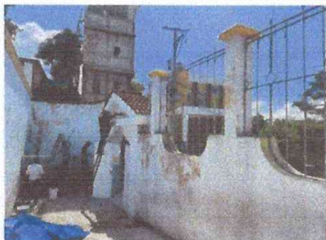
Foto 1: Aplicación de pintura
