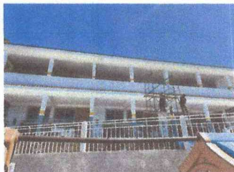
Foto 2: aplicación de pintura segundo nivel
