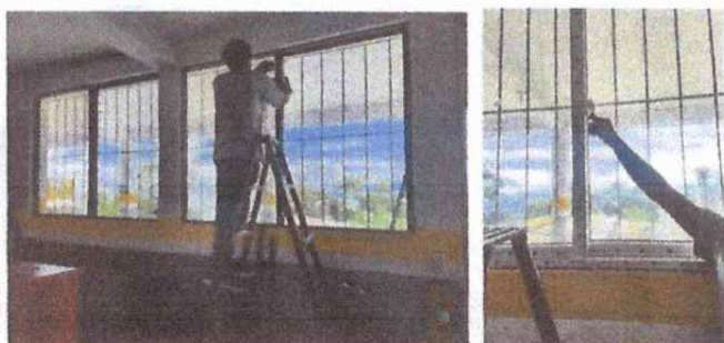
Foto 3: desinstalacion de ventanas antiguas para la colocacion de las nuevas
