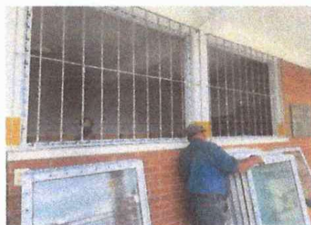
Foto 4: instalacion de marco de ventanas nuevas
