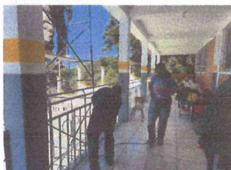
Foto 4: Lijado y de barandas para la aplicación de nueva pintura y reparacion
