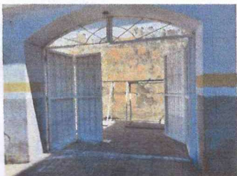
Foto 5: Reparacion de porton y aplicación de nueva pintura.
