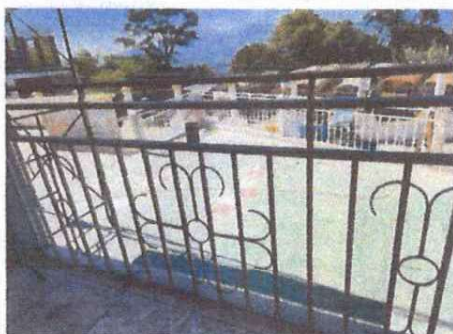
Foto 3: Lijado y de barandas para la aplicación de nueva pintura y reparacion
