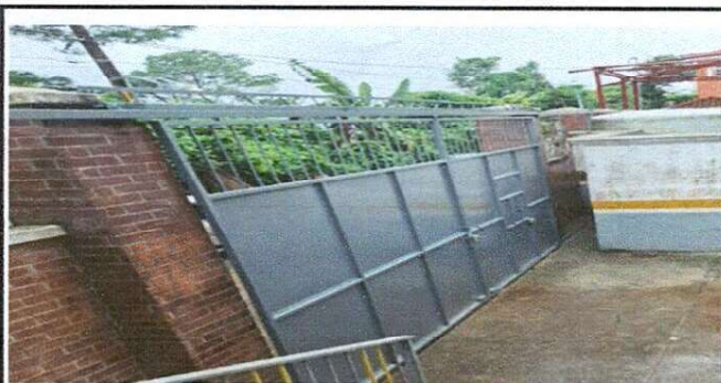
REPARACION DE PORTON
