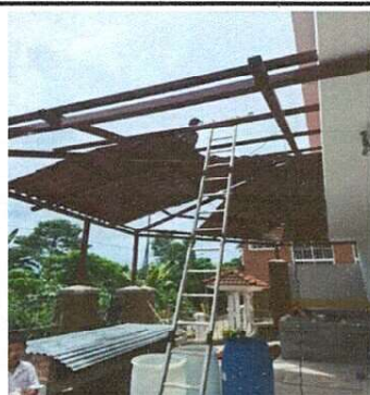
TECHO DE COCINA
