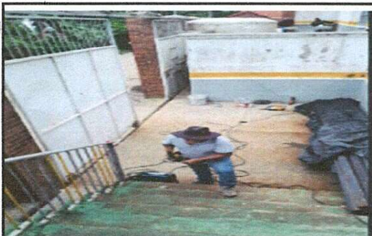
REPARACION DE PORTON
