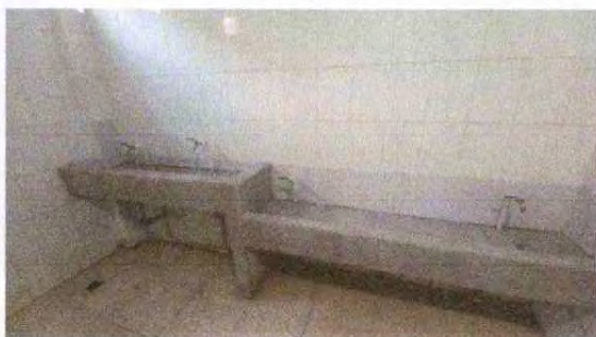
Foto7: Sustitución de lavamanos por piletas con azulejo en primer nivel.
