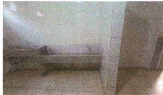
Foto 8: Sustitución de lavamanos por piletas con azulejos en primer nivel.
