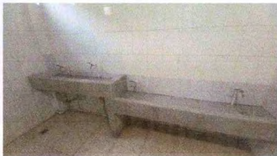
Foto 7: Sustrución de lavamanos por piletas con azulejo en primer nivel.
