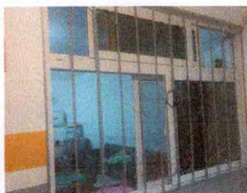
Foto 11: Sustrución de ventana fija por ventana de pvc corrediza en el área de cocina.
