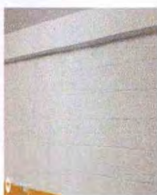
Foto 5: Impermeabilización de paredes por filtración de agua, repelo y cernido, edificio 2 segundo nivel.
