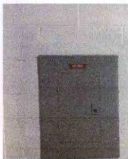
Foto 3: Reparación del sistema eléctrico central con cambio de tablero monofásico por deterioro en planta baja.
