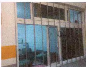
Foto 11: Sustitución de ventana fija por ventana de pvc corrediza en el área de cocina.
