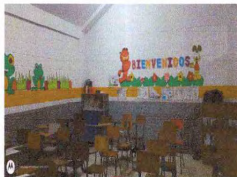
Foto 2: Impermeabilización de paredes por filtración de agua, repelo y cernido segundo nivel.
