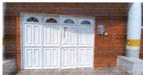
Foto2: Mantenimiento de portón de metal en entrada principal cambio de pintura.
