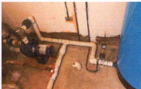
Foto 1: Mantenimiento y reparación de cisterna y depósito de agua con cambio de bomba hidráulica por mal funcionamiento.
