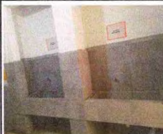
Foto 12: Sustrución de azulejo en baños de planta baja.
