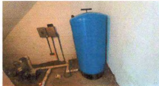
Foto 2: Cambio de tanque hidroneumático por fallas en el funcionamiento.
