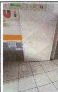
Foto 10: Mantenimiento de Puertas en segundo nivel (pintura)
