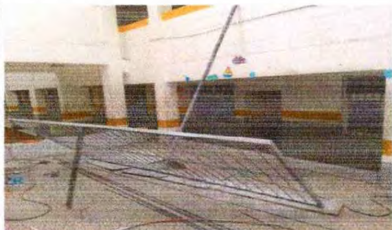
Foto1: Mantenimiento de barandas (limpieza y pintura de barandas ubicadas en gradas del edificio)
