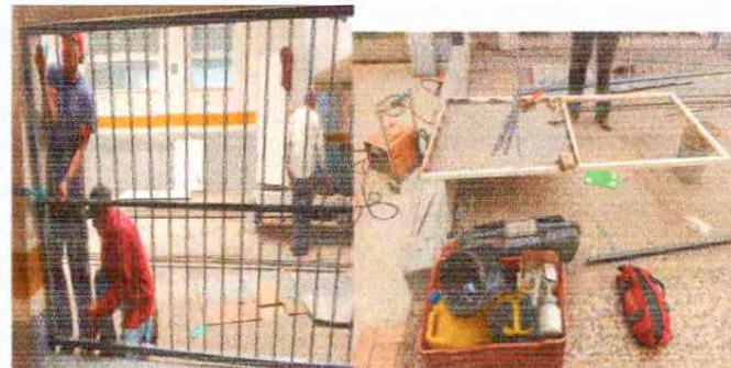
Foto 2: Instalación de barandas para seguridad de alumnos en parte lateral del escenario.
