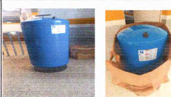
Foto 2: Cambio de tanque hidroneumático por fallas en el funcionamiento
