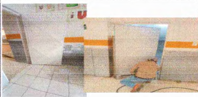
Foto 3: Sustitución de chapas de puertas de salón por deterioro mal funcionamiento y pintura.
