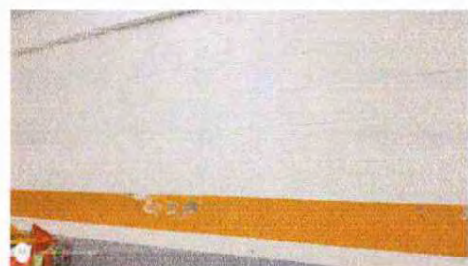
Foto 3: Impermeabilización de paredes por filtración de agua, repelo y cernido segundo nivel.
