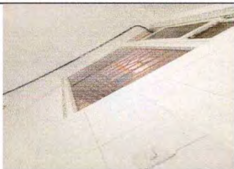
Foto 11: Sustitución de ventana fija por ventana de pvc corrediza en el área de cocina.
