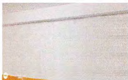
Foto 5: Impermeabilización de paredes por filtración de agua, repelo y cernido, edificio 2 segundo nivel.
