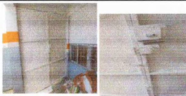
Foto 5: Mantenimiento y portón de metal lateral, cambio de chapa por deterioro y mal funcionamiento.
