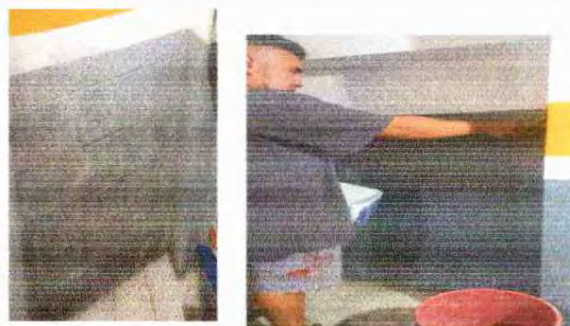
Foto 6: Impermeabilización de paredes por filtración de agua, repelo y cernido, bodega de la escuela.
