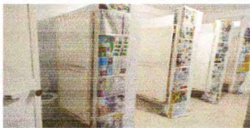
Foto 9: Foto 9: Manenimiento de puertas, sanitarios nivel 1(pintura)
