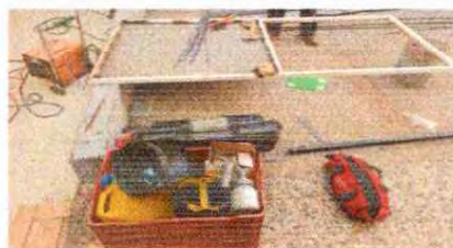
Foto 10: Mantenimiento de Puertas en segundo nivel (pintura)
