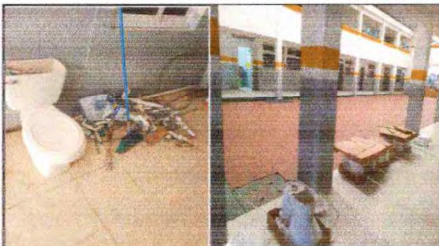
Foto 4: Sustitución de sanitarios completos por deterioro.
