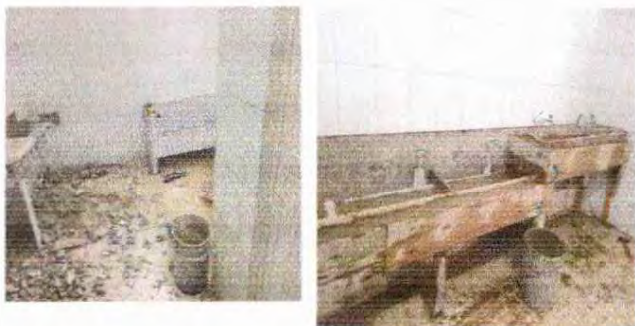
Foto7: Sustitución de lavamanos por piletas con azulejo en primer nivel,
