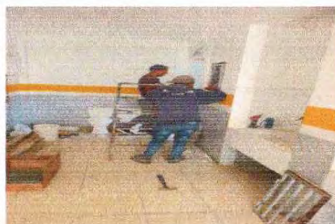
Foto 4: Sustitución de sanitarios completos por deterioro.
