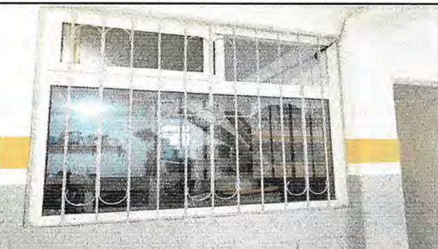
Foto 5: Sustrucción de ventana fija por ventana de PVC corrediza en el área de cocina
