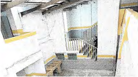
Foto 1: Mantenimiento de barandas (limpieza y pintura de barandas ubicadas en gradas del edificio)
