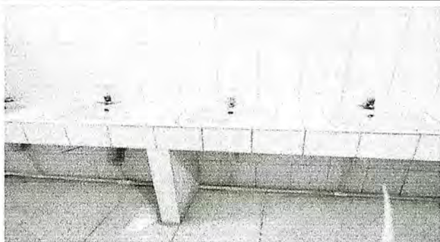
Foto 1: Sustrucción de lavamanos por pileta con azulejo en primer nivel
