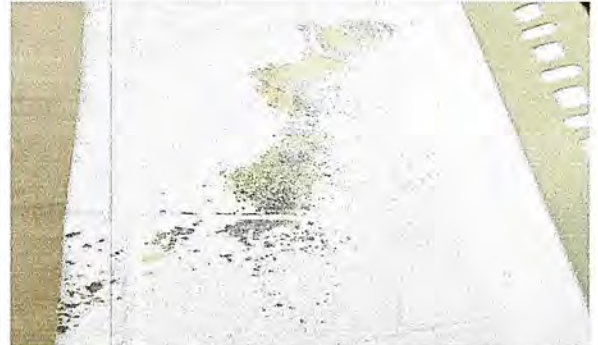
Foto 4: Impermeabilización de paredes por filtración de agua, repello y cernido, segundo nivel
