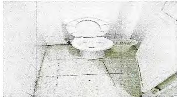
Foto 4: Sustitución de dos sanitarios completos por deterioro
