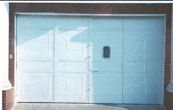
Foto 2: MANTENIMIENTO DE PORTON
