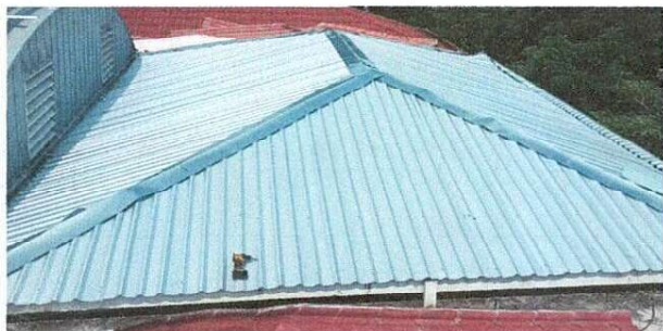
Foto1: CAMBIO DE TECHO
