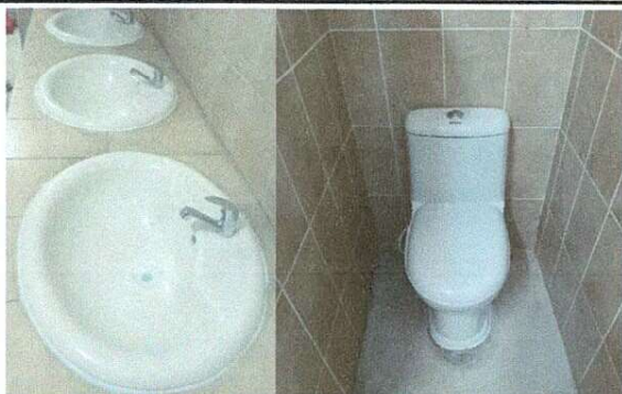
Foto 3: CAMBIO DE SANITARIOS Y LLAVES DE LAVAMANOS
