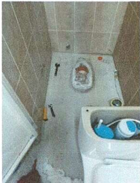
Foto 3: CAMBIO DE SANITARIOS
