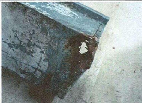
Foto 5: CANAL DE AGUA PLUVIAL
