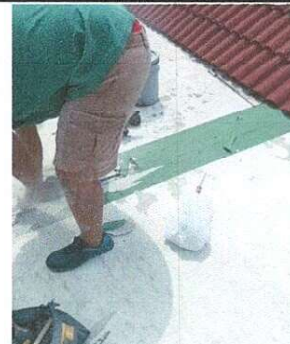
Foto 6: REZANE E IMPERMEABILIZACION DE GRIETA DE MOVIMIENTO
