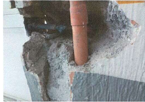
Foto 2: MANTENIMIENTO DE PORTON
