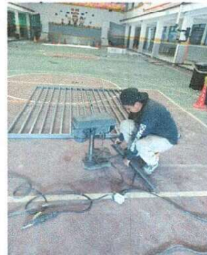
Foto 4: FABRICACION DE BARANDAS DE ACCESO DE SEGURIDAD
