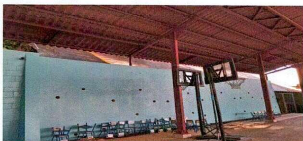
Foto 5: PINTURA DE MURO DE CONTENCION A 2 MANOS CONCLUIDA
