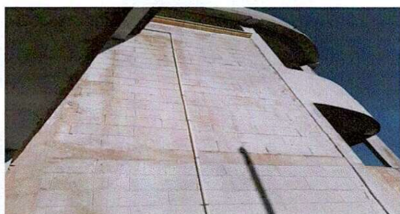
FOTO 3. DISTRIBUCION DE AGUA VARIOS ESPACIOS DE LA ESCUELA TERMINADA
