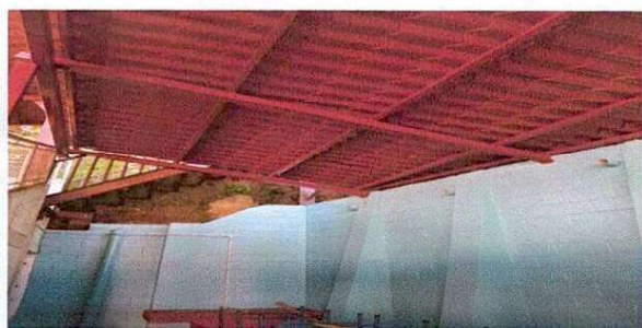
FOTO 3. BODEGA ANEXA A POLIDEPORTIVO TECHO TERMINADA
