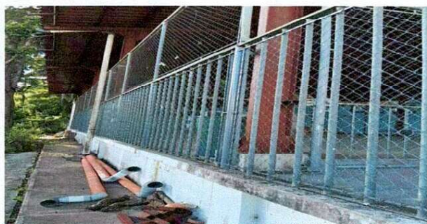
FOTO 1 TRABAJO TERMINADO COLOCACION DE MALLA EN CANCHA
