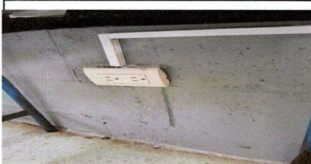
Foto 2: DISTRIBUCIÓN DE LUZ EN 2 NIVELES CONCLUIDA
