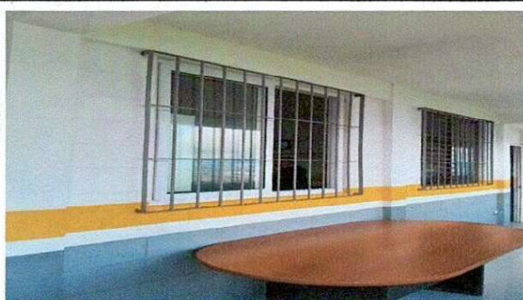
FOTO 1 INTALACION DE VENTANAS EN AULAS TERMINADA
