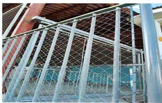
FOTO 2 TRABAJO TERMINADO COLOCACION DE MALLA
