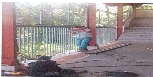
Foto 6: TRABAJO INTALACION DE MALLA POLIDEPORTIVO
