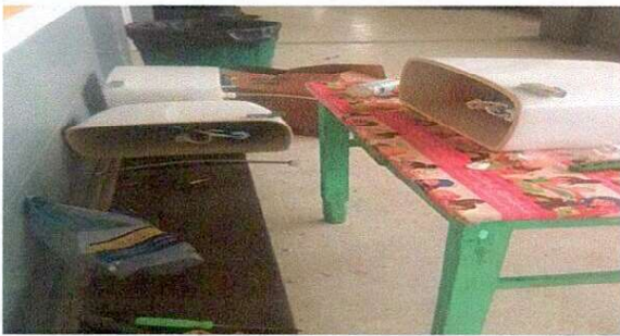
Foto 1: CAMBIO DE ACCESORIOS SANITARIOS PRIMER NIVEL
