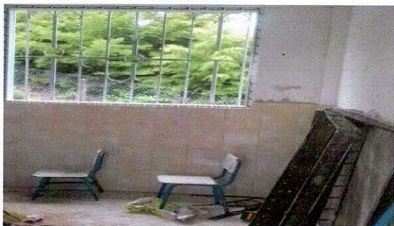
FOTO 3. CAMBIO VENTANAS COCINA
