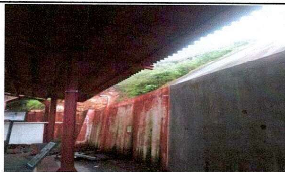
Foto 4: EXTENSION TECHO POLIDEPORTIVO
