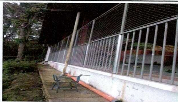
Foto 5: TRABAJO INSTALACION DE MALLA
