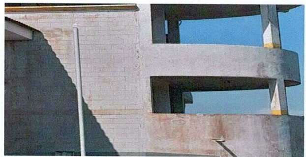
Foto 6: DISTRIBUCIÓN DE AGUA POTABLE
