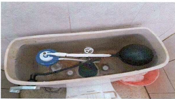
Foto 3: CAMBIO DE ACCESORIO DE SANITARIO DIRECCION
