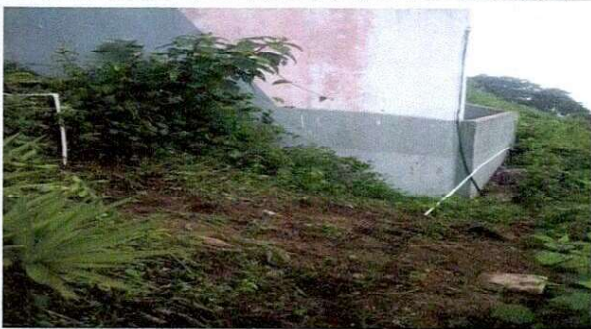
Foto 5: TRABAJOS DE DISTRIBUCION DE AGUA POTABLE
