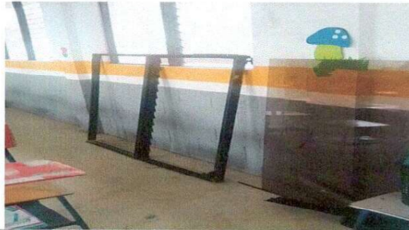
Foto 2: CABIO DE VENTANAS 2DO NIVEL
