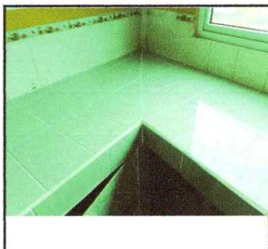
REPARACIÓN DE AZULEJO
