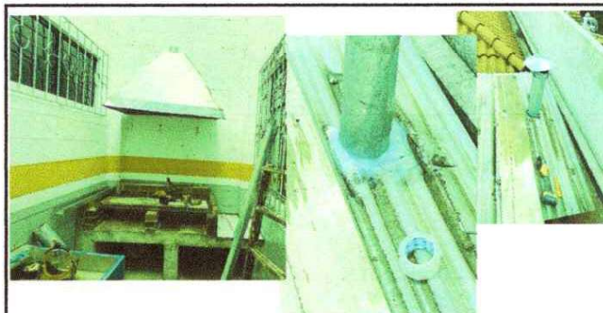
INSTALACIÓN DE CHIMENEA
