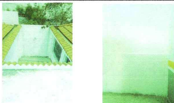
REPARACIÓN DE MURO DE BLOCK
