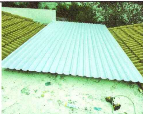
REPARACIÓN DE LÁMINA TIPO ALUZINC, INSTALACIÓN DE ESTRUCTURA METALICA
