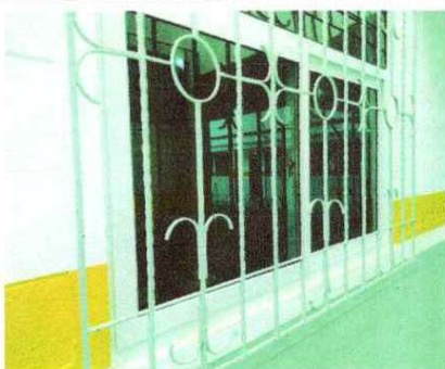
REPARACIÓN DE VENTANAS
