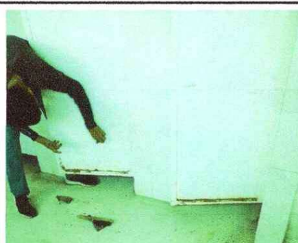
REPARACIÓN DE PUERTAS
