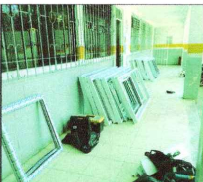
REPARACIÓN DE VENTANAS
