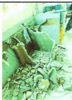
SUSTITUCIÓN DE PILA DE CONCRETO
