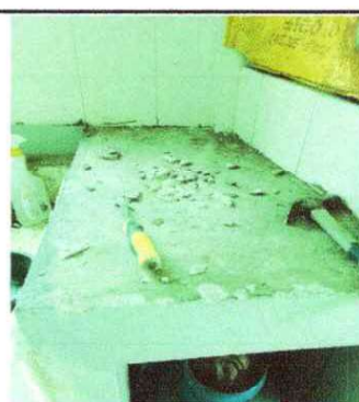
REPARACIÓN DE AZULEJO
