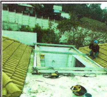
REPARACIÓN DE LÁMINA TIPO ALUZINC, INSTALACIÓN DE ESTRUCTURA METALICA
