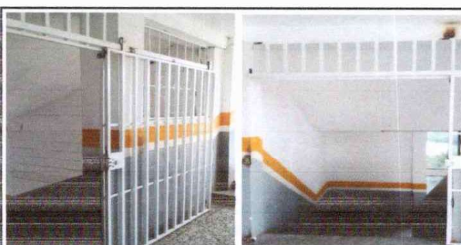
Foto 10 y 11: Mantenimiento de baranda; Instalacion de marcos y rejas de graderios para la seguridad de los alumnos. ( fase 2)
