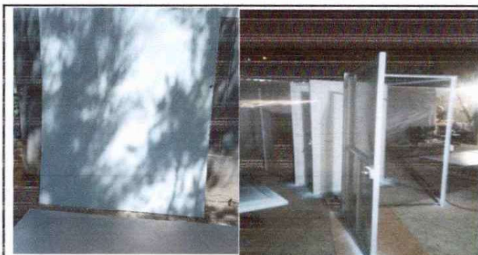
Foto 3: Foto 5 y 6: Sustitución de marco y puertas de madera en mal estado por marco y puertas de metal pintada e instalada.
