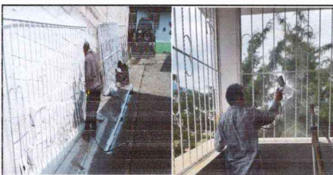
Foto 8 y 9: Mantenimiento de baranda; Instalacion de marcos y rejas de graderios para la seguridad de los alumnos ( fase 1)
