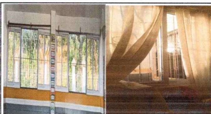
Foto 7: Ventanas: sustitucion de marco de alumninio con paletas de vidrio por ventana de PVC corrediza con sus respectivo vidrio.
