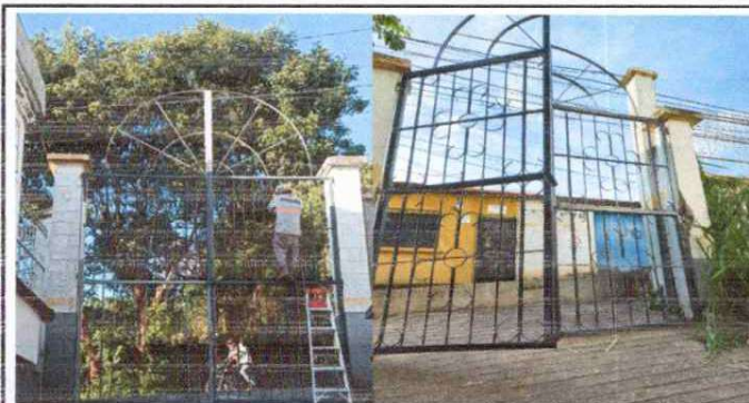
Foto 3 y 4 : Mantenimientos de portones deteriorado y oxidado por lamina nueva, reparacion y pintado.
