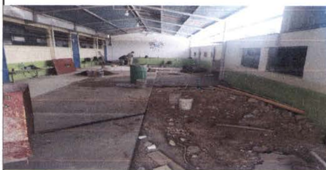
Foto 8: PISO- corredor principal, fundición de partes del corredor.
