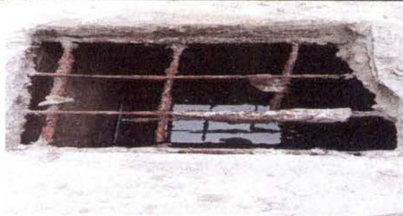
Foto 12: REPARACIÓN EN RED DE DRENAJE- tapadera de fosa ubicada en el corredor principal. Preparación para colocación de tapadera.
