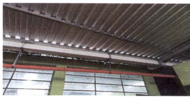
Foto 10: CANALES Y BAJADAS DE AGUA PLUVIAL- cocina y corredor de preparatoria, colocación de canal metálico.
