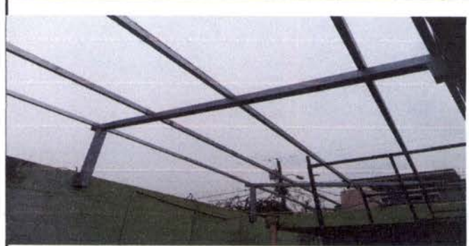
Foto 4: ESTRUCTURA DE TECHO - colocación de estructura portante.
