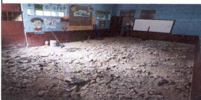
Foto 5: PISO - salón de segundo A, demolición y retiro de piso de concreto.
