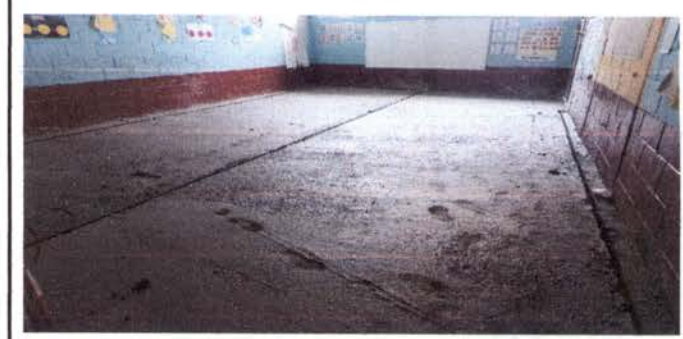
Foto 6: PISO - salón de segundo A, fundición de torta de concreto.
