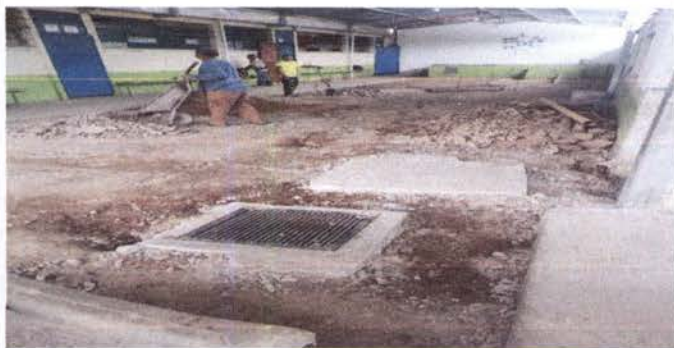
Foto 7: PISO- corredor principal, demolición, extracción de ripio y preparación del terreno para la fundición.
