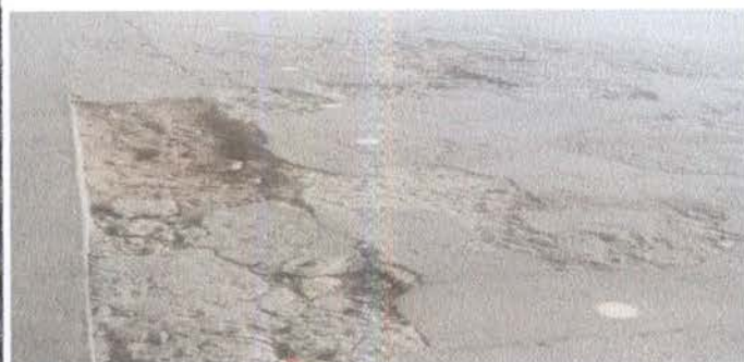
Foto 7: PISO- corredor principal, partes en donde ya se levantó la torta de concreto.
