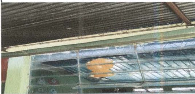
Foto 10: CANALES Y BAJADAS DE AGUA PLUVIAL- cocina y corredor de preparatoria, los canales colapsaron, debido a la corrosión y el mal estado de los mismos.
