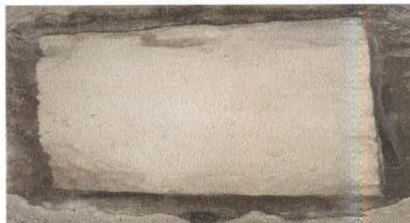
Foto 12: REPARACIÓN EN RED DE DRENAJE- tapadera de fosa ubicada en el corredor principal, dañada en sus orillas. No cubre en su totalidad, a punto de caer a la fosa.
