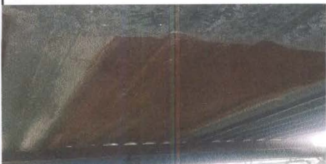
Foto 1: CUBIERTA DE LÁMINA - cocina, corredor de preparatoria. techo en mal estado, láminas oxidadas y posee filtraciones de agua.
