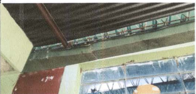
Foto 9: CANALES Y BAJADAS DE AGUA PLUVIAL- cocina y corredor de preparatoria, canales en mal estado.
