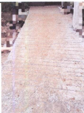
Foto 3: instalación de rampa en entrada de 3.0mts de largo x 1.20m de ancho
