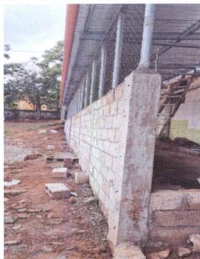
Foto1: Levantado de muro perimetral de block con tubo hg y malla galvanizada, soleras intermedias y columnas.
