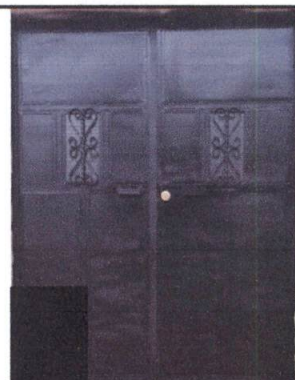
Foto 4: Instalación de portón de doble hoja de 1.54 mts. De ancho y de alto 2.00 mts de alto con chapa Yale pasadores y vaentanas.
