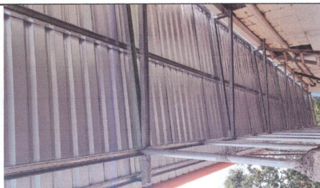
Foto 5: Instalación de estructura de soporte de metal utilizando costanera 3 x 2 galvanizada de 22 mts de largo y 3.10 mts de ancho
