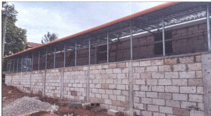
Foto 2: Levantado de muro perimetral de block con tubo hg y malla galvanizada, soleras intermedias y columnas. Y instalación de canal para aguas pluviales.
