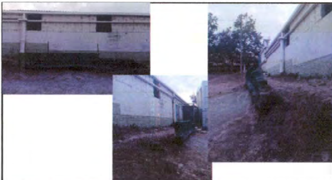
Foto 4: Sustitución de muro perimetral de block con tubo hg y malla galvanizada, soleras intermedias y columnas.
