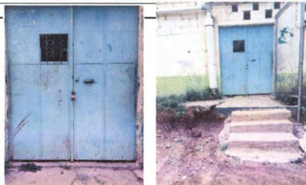
Foto 2: Sustitución de portón de metal.
