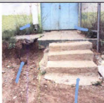
Foto1: Sustrucción de gradas de entrada principal de 1.35 de largo x 30x20. y instalación de rampa en entrada de 2.0mts de largo x 1.00m de ancho.
