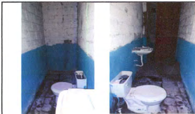
Foto1: Sustitución de piso cerámico, repello de pared, instalación de azulejo, sustitución de inodoro, reparación de lavamanos, sustitución de mezcladora para ducha.
