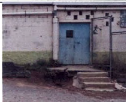
Foto 2: Sustrucción de gradas de entrada principal de 1.35 de largo x 30x20. y instalación de rampa en entrada de 2.0mts de largo x 1.00m de ancho.
