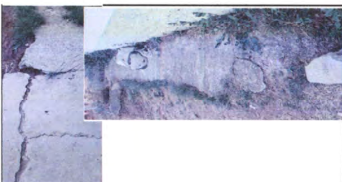
Foto 6: Sustitución de muro perimetral
