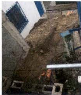
Foto 9: Reparación de Red de Drenaje de aguas pluviales en patio
