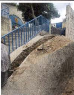
Foto 9: Reparación de Red de Drenaje de aguas pluviales en patio
