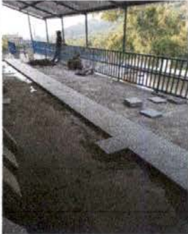
Foto 4: Sustitución de piso de torta de concreto, se colocará en el corredor del instituto
