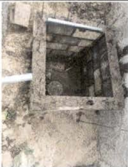
Foto 9: Reparación de Red de Drenaje de aguas pluviales en patio
