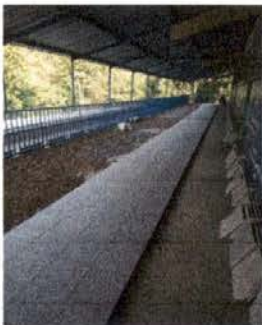
Foto 4: Sustitución de piso de torta de concreto, se colocará en el corredor del instituto
