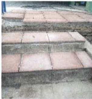
Foto 5: Sustitución de piso de torta de concreto, se colocará en el graderío del instituto
