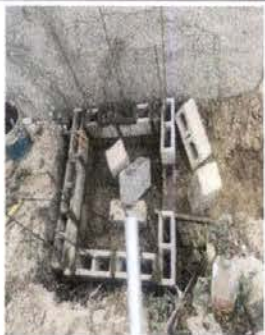
Foto 9: Reparación de Red de Drenaje de aguas pluviales en patio
