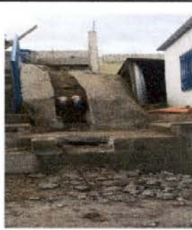
Foto 9: Reparación de Red de Drenaje de aguas pluviales en patio
