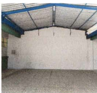
Foto 11: Reparación de repello del escenario. Incluye quitar repello, repello, cernido, alisado y tallado.
