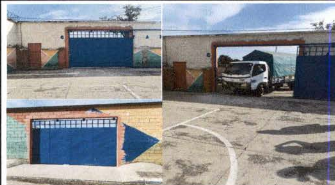
Foto 2: Ampliación de puerta del área de la cancha a 4 m de ancho x 3.00 de alto. Incluye: demolición de muro, demolición de banqueta de 2.50 x 4, fundición de columnas, rampa, tapaderas, dinteles, tallado, instalación de riel y pintura.
