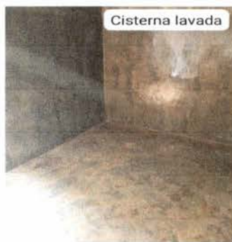
Foto7: antenimiento de cisterna y bomba de agua. Incluye lavado de cisterna de 1.80 de profundidad y 3.20 metros, mantenimiento preventivo para bomba de agua.
