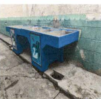
Foto 9: Sustitución de dos pilas de dos lavaderos. Incluye: desmontar, instalar pilas, instalar drenaje y sustitución de chorros.
