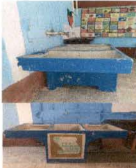
Foto 10: Instalación de pila en el área de la cocina. Incluye instalación, drenaje y caja de registro. Instalación de botaguas y aplicación de chapopote
