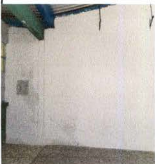
Foto 11: Reparación de repello del escenario. Incluye quitar repello, repello, cernido, alisado y tallado.
