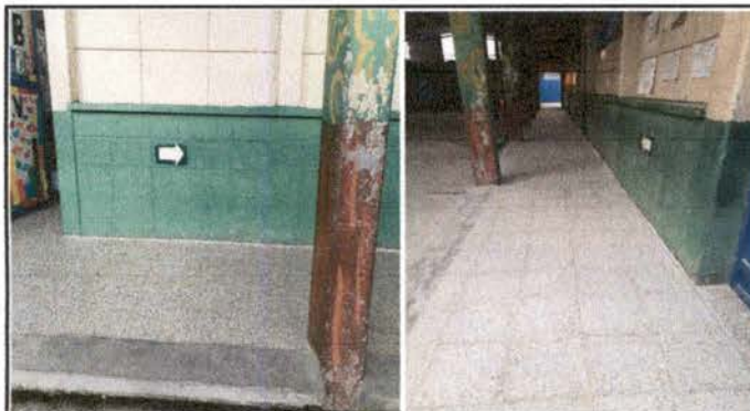
Foto 3: Sustitución de piso cerámico por piso granito en corredores de patio central
