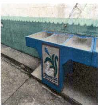
Foto 9: Sustitución de dos pilas de dos lavaderos. Incluye: desmontar, instalar pilas, instalar drenaje y sustitución de chorros.
