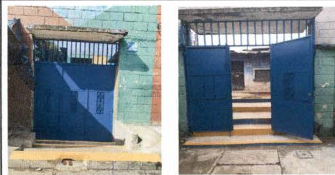
Foto 5: Reparación de banqueta de la entrada principal que incluye: demoler rampa y hacer 3 gradas e instalación de tubo de 3 de tubo de 3" para guas pluviales.
