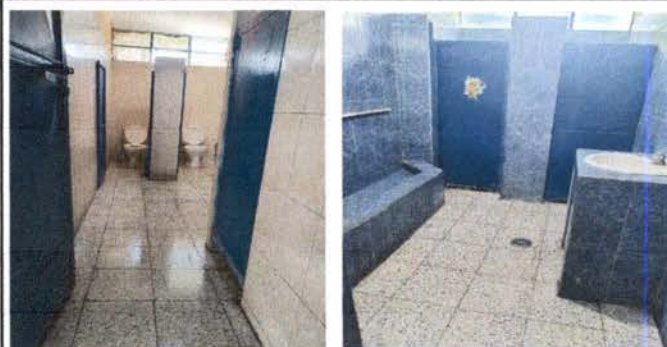
Foto 6: Servicios sanitarios de niños y niñas en patio central. Incluye: Sustitución de piso cerámico por granito, desinstalar 6 inodoros, levantar piso, nivelar e instalar piso y colocar los inodoros. Sustitución de accesorios, reparación de mengitorio en sanitario de niños, desfogar drenaje, sustitución de dos reposaderas.
