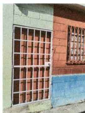
Foto 8: : Fabricación e instalación de puerta de reja en el área de cocina (Primer nivel)
