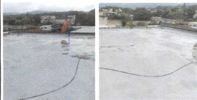
Foto 1: Impermeabilización de losa del laboratorio de computación y reparación de pañuelos.
