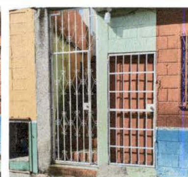
Foto 8: : Fabricación e instalación de puerta de reja en el área de cocina (Primer nivel)
