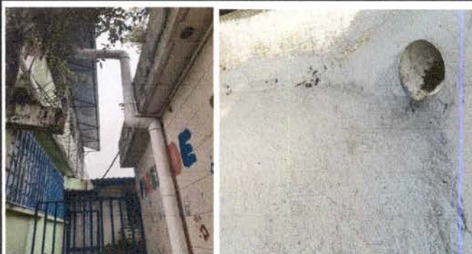
Foto 4: Sustitución de bajada de agua pluvial de 4" 160 PSI de terraza de laboratorio de computación.
