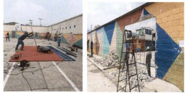
Foto 2: Ampliación de puerta del área de la cancha a 4 m de ancho x 2.50 de alto. Incluye: demolición de muro, demolición de banqueta de 2.50 x 4, fundición de columnas, rampa, tapaderas, dinteles, tallado, instalación de riel y pintura.
