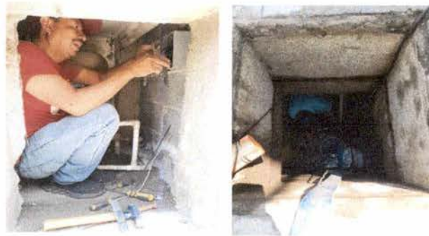
Foto7: antenimiento de cisterna y bomba de agua. Incluye lavado de cisterna de 1.80 de profundidad y 3.20 metros, mantenimiento preventivo para bomba de agua.
