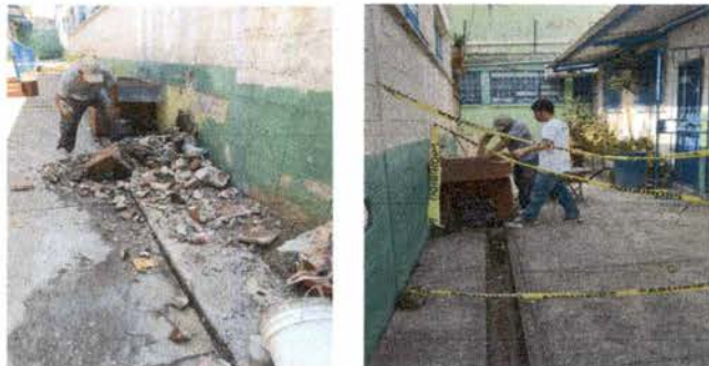
Foto 9: Sustitución de dos pilas de dos lavaderos. Incluye: desmontar, instalar pilas, instalar drenaje y sustitución de chorros.
