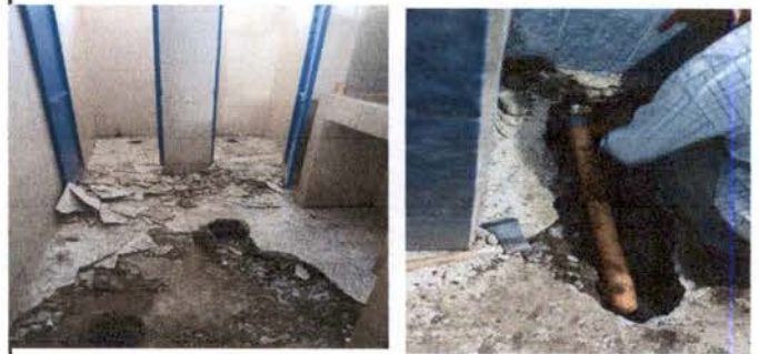
Foto 6: Servicios sanitarios de niños y niñas en patio central. Incluye: Sustitución de piso cerámico antideslizante, desinstalar 3 inodoros, levantar piso, nivelar e instalar piso y colocar los inodoros. Sustitución de accesorios, reparación de mingitorio en sanitario de niños, destapar drenaje, sustitución de dos reposaderas.
