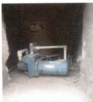
Foto 7: antenimiento de cisterna y bomba de agua. Incluye lavado de cisterna de 1.80 de profundidad y 3.20 metros, mantenimiento preventivo para bomba de agua.
