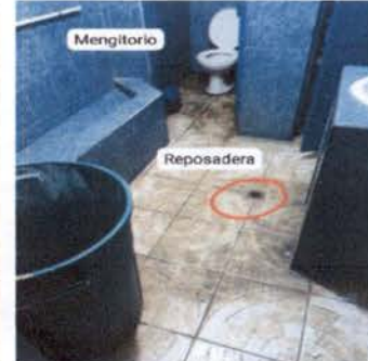
Foto 6: Servicios sanitarios de niños y niñas en patio central. Incluye: Sustitución de piso cerámico antideslizante, desinstalar 3 inodoros, levantar piso, nivelar e instalar piso y colocar los inodoros. Sustitución de accesorios, reparación de mingitorio en sanitario de niños, desinstalar drenaje, sustitución de dos reposaderas.
