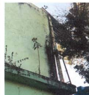
Foto 4: Sustitución de bajada de agua pluvial de 4" 160 PSI de terraza de laboratorio de computación.
