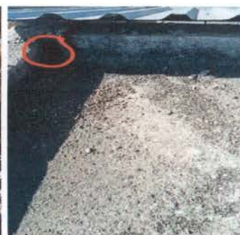
Foto 4: Sustitución de bajada de agua pluvial de 4" 160 PSI de terraza de laboratorio de computación.
