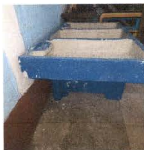
Foto 10: Instalación de pila en el área de la cocina. Incluye instalación, drenaje y caja de registro. Instalación de botaguas y aplicación de chapopote
