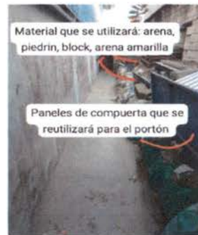
Foto 2: Ampliación de puerta del área de la cancha a 4 m de ancho x 2.50 de alto. Incluye: demolición de muro, demolición de banquetta de 2.50 x 4, fundición de columnas, rampa, tapaderas, dinteles, tallado, instalación de riel y pintura.
