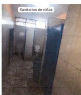
Foto 6: Servicios sanitarios de niños y niñas en patio central. Incluye: Sustitución de piso cerámico antideslizante, desinstalar 3 inodoros, levantar piso, nivelar e instalar piso y colocar los inodoros. Sustitución de accesorios, reparación de mingitorio en sanitario de niños, desinstalar drenaje, sustitución de dos reposaderas.
