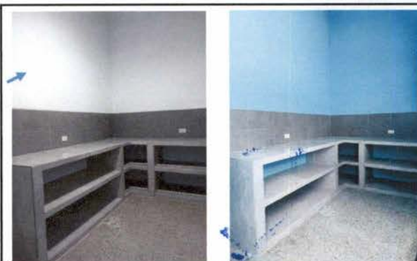
Foto 4: REPELLO Y CERNIDO: Acabado, base gris y base blanca Monocapa. Área de cocina
