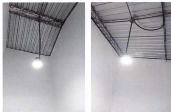
Foto 10: REPARACIÓN DE SISTEMA ELÉCTRICO: Cambio de altura y sustitución de luminaria en bodega de cocina.
