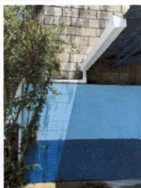
Foto 15: REPARACIÓN DE BAJADA DE AGUA PLUVIAL Reparación de caída de agua sobre muro afuera de salón. Incluye: Colocación de 1.00m. De canal de alto caudal pvc y colocación de bajada con tubo pvc de 3"
