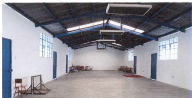
Foto 8: REPELLO Y CERNIDO Acabado, Base Gris y base blanca Monocapa, área de salón interior y exterior
