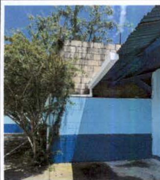
Foto 15: REPARACIÓN DE BAJADA DE AGUA PLUVIAL Reparación de caída de agua sobre muro afuera de salón. Incluye: Colocación de 1.00m. De canal de alto caudal pvc y colocación de bajada con tubo pvc de 3"
