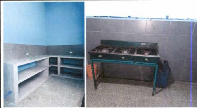
Foto 2: REPARACIÓN DE COCINA: Construcción de 4ml de nuevo mueble y colocación de azulejo área de estufa.
