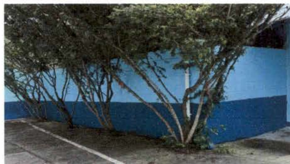
foto 12: PINTURA EN MUROS EXTERIORES : Aplicación de pintura
