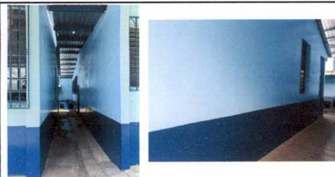
Foto 11. PINTURA EN MUROS EXTERIORES Aplicación de pintura.
