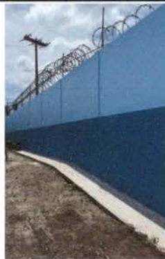
Foto 14: REPARACIÓN DE BANQUETAS DE CONCRETO: Fundición de banqueta, Incluye: nivelación, compactación + fundición de concreto 3,000 psi con acabado rustico. Colocación de chorro
