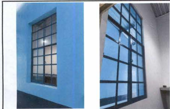
Foto 1: VENTANA: Apertura de vano para ventana de 1x1.70m e instalación de ventana
