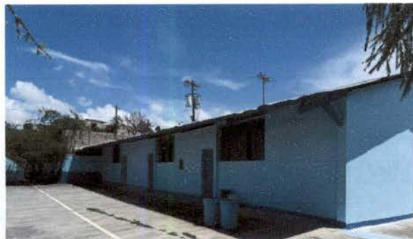
foto 13: PINTURA EN MUROS EXTERIORES: Aplicación de acabado y pintura área exterior de salón.
