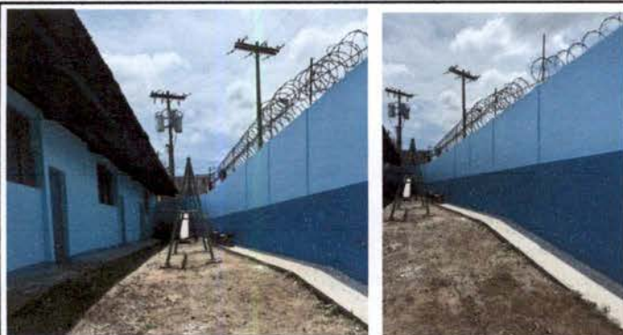
Foto 9: REPELLO Y CERNIDO : Acabado, base Gris y base blanca Monocapa, área muro perimetral.
