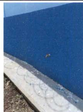
Foto 14: REPARACIÓN DE BANQUETAS DE CONCRETO: Fundición de banqueta, Incluye: nivelación, compactación + fundición de concreto 3,000 psi con acabado rustico. Colocación de chorro
