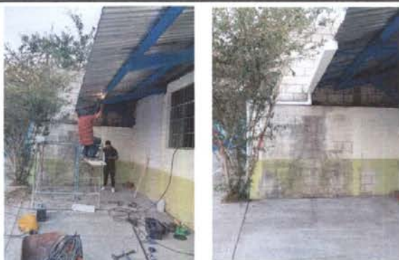
Foto 15: REPARACIÓN DE BAJADA DE AGUA PLUVIAL Reparación de caída de agua sobre muro afuera de salón. Incluye: Colocación de 1.00m. De canal de alto caudal pvc y colocación de bajada con tubo pvc de 3"
