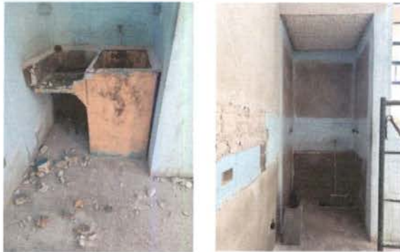
Foto 7: INSTALACIÓN DE PILA: Sustitución de pila de un lavadero, área interior(cocina)
