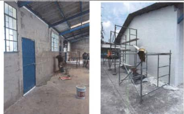
Foto 8: REPELLO Y CERNIDO Acabado, Base Gris y base blanca Monocapa, área de salón interior y exterior
