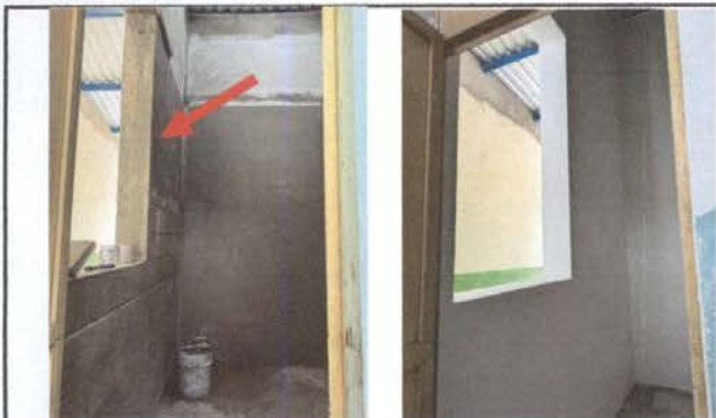
Foto 1: VENTANA: Apertura de vano para ventana de 1x1.70m e instalación de ventana
