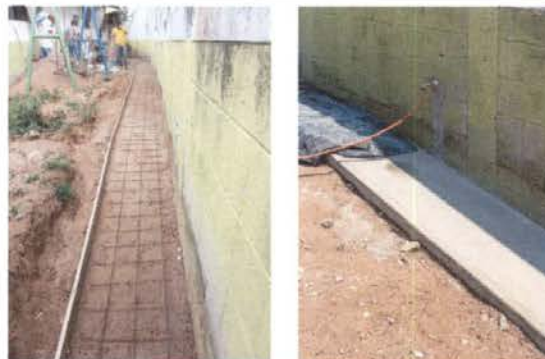
Foto 14: REPARACIÓN DE BANQUETAS DE CONCRETO: Fundición de banqueta, Incluye: nivelación, compactación + fundición de concreto 3,000 psi con acabado rustico. Colocación de chorro
