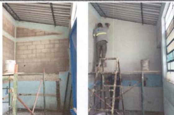
Foto 4: REPELLO Y CERNIDO: Acabado, base gris y base blanca Monocapa. Área de cocina
