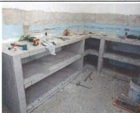
Foto 2: REPARACIÓN DE COCINA: Construcción de 4ml de nuevo mueble y colocación de azulejo área de estufa.
