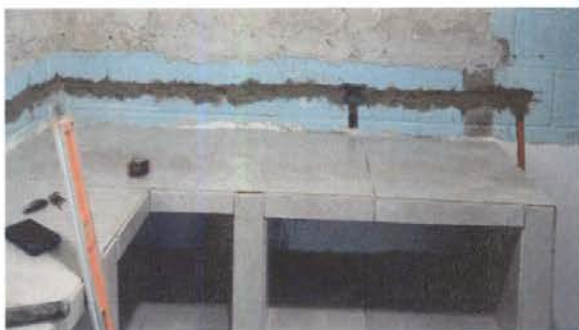
Foto 5: REPARACIÓN DE SISTEMA ELÉCTRICO: Instalación de tomacorrientes dobles en mueble de cocina.
