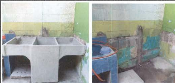
Foto 6: INSTALACIÓN DE PILA: Sustitución de pila de un lavadero, área exterior (patio)
