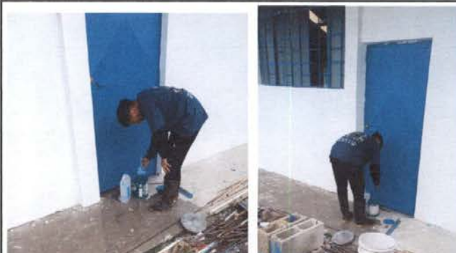
Foto 16: PUERTAS DE METAL: Mantenimiento a 3 puertas en salón. Incluye: Desmontaje, lijado en áreas oxidadas, limpieza, pintura y aplicación de lubricante en bisagras.
