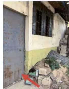
Foto 16: PUERTAS DE METAL: Mantenimiento a 3 puertas en salón. Incluye: Desmontaje, lijado en áreas oxidadas, limpieza, pintura y aplicación de lubricante en bisagras.
