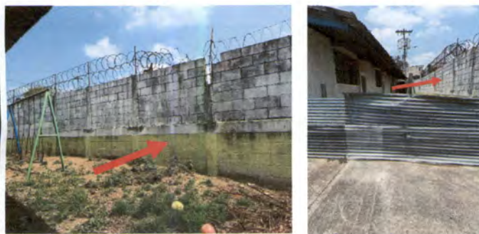
Foto 9: REPELLO Y CERNIDO : Acabado, base Gris y base blanca Monocapa, área muro perimetral.
