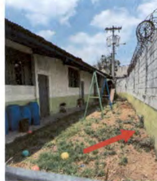
Foto 14: REPARACIÓN DE BANQUETAS DE CONCRETO: Fundición de banqueta en área de jardín. Incluye: nivelación, compactación + fundición de concreto 3,000 psi con acabado rustico
