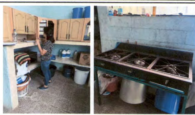
Foto 2: REPARACIÓN DE COCINA: Demolición de mueble de cocina actual porque no es funcional por altura de 1.24m, Construcción de 4ml de nuevo mueble y colocación de azulejo área de estufa.
