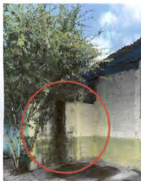
Foto 15: REPARACIÓN DE BAJADA DE AGUA PLUVIAL Reparación de caída de agua sobre muro afuera de salón. Incluye: Colocación de 1.00m. De canal de alto caudal pvc y colocación de bajada con tubo pvc de 3"
