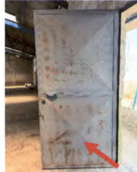
Foto 16: PUERTAS DE METAL: Mantenimiento a 3 puertas en salón. Incluye: Desmontaje, lijado en áreas oxidadas, limpieza, pintura y aplicación de lubricante en bisagras.
