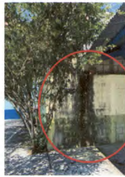
Foto 15: REPARACIÓN DE BAJADA DE AGUA PLUVIAL Reparación de caída de agua sobre muro afuera de salón. Incluye: Colocación de 1.00m. De canal de alto caudal pvc y colocación de bajada con tubo pvc de 3"
