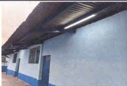
FOTO 5: INSTALACIÓN DE LÁMPARAS TIPO LED DE 2 TUBOS EN ÁREA EXTERIOR DE SALÓN
