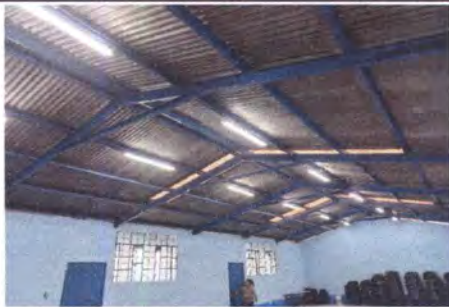
FOTO 3: INSTALACIÓN DE LÁMPARAS TIPO LED DE 2 TUBOS EN INTERIOR DE SALÓN
