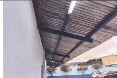
FOTO 4: INSTALACIÓN DE LÁMPARAS TIPO LED DE 2 TUBOS EN ÁREA EXTERIOR DE SALÓN
