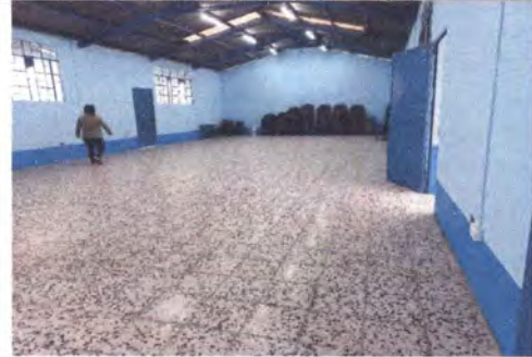
FOTO 2: SUSTITUCIÓN DE PISO DE GRANITO EN SALÓN
