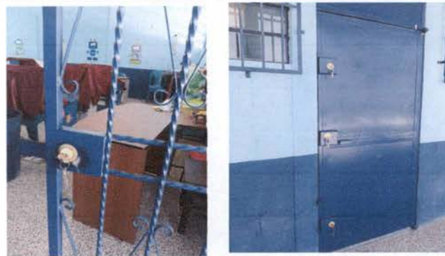
Foto 2: Sustitución de chapas en Computación
