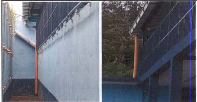
Foto 6: Sustitución de bajadas de agua ( tubo de 4") de agua mantenimiento de canales del módulo 1 de Primaria y salón de usos múltiples.
