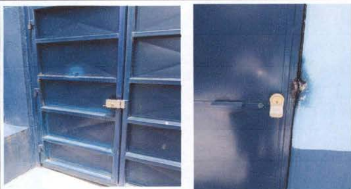
Foto 3: Sustitución de chapa del depósito de basura de la jornada matutina (se arruinó la chapa por eso se usa candado) y del portón( se juega la llave).
