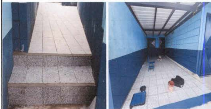
Foto 4: Sustitución de torta de concreto por piso de granito corredor Preprimaria, también el espacio de Tienda Escolar.
