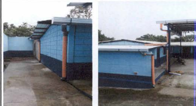
Foto 2: Trabajo de canales y bajadas de agua en aulas de Preprimaria y techo de Tienda Escolar
