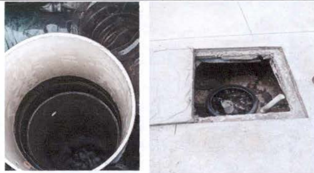
Foto 2: Limpieza de fosa séptica
