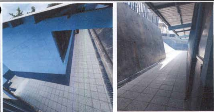
Foto 5: Sustitución de torta de concreto por piso de granito corredor de Primaria módulo 2.
