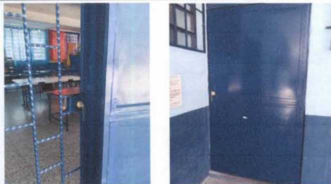
Foto1: Sustitución de chapas en CREA
