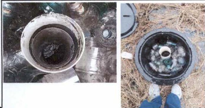
Foto1: Limpieza de fosa séptica
