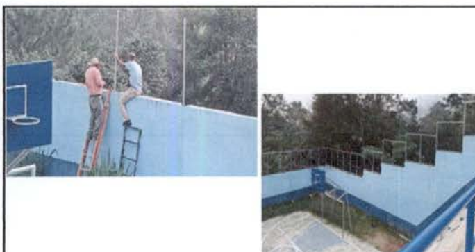
Foto 3: Colocación de tubo hg y malla galvanizada en muro perimetral donde se encuentra la cancha polideportiva
