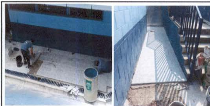
Foto 5: Sustitución de torta de concreto por piso de granito corredor de Primaria módulo 2.
