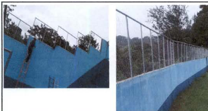
Foto 5: Colocación de tubo hg y malla galvanizada en muro perimetral donde se encuentra la cancha polideportiva
