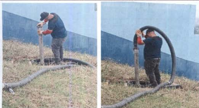
Foto1: Limpieza de fosa séptica
