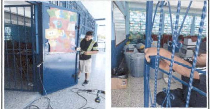
Foto 2: Sustitución de chapas en Computación
