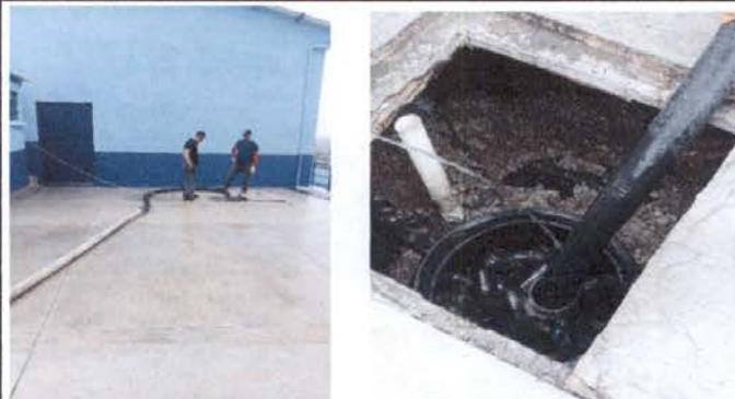
Foto 2: Limpieza de fosa séptica
