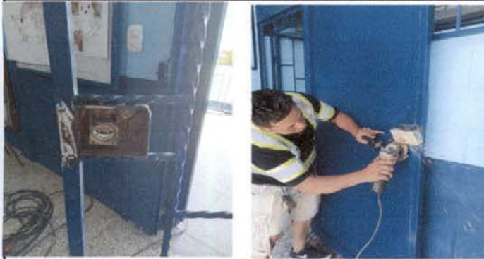
Foto1: Sustitución de chapas en CREA
