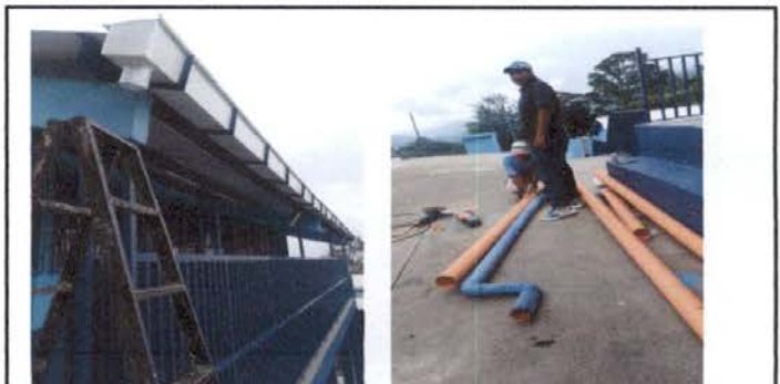
Foto 6: Foto 3: Sustitución de bajadas de agua ( tubo de 4") de agua mantenimiento de canales del módulo 1 de Primaria y salón de usos múltiples.
