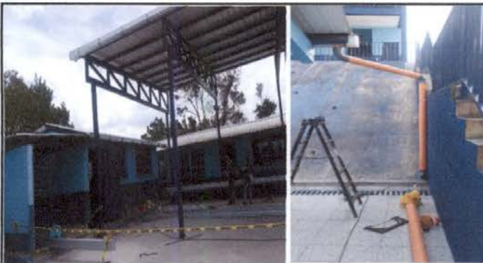
Foto 3: Trabajo de canales y bajadas de agua en techo de patio de Preprimaria y techo de módulo 2 de Primaria.
