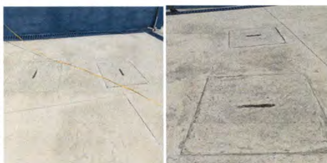
Foto 2: Limpieza de fosa séptica
