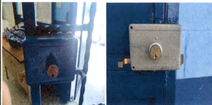
Foto1: Sustitución de chapas en CREA
