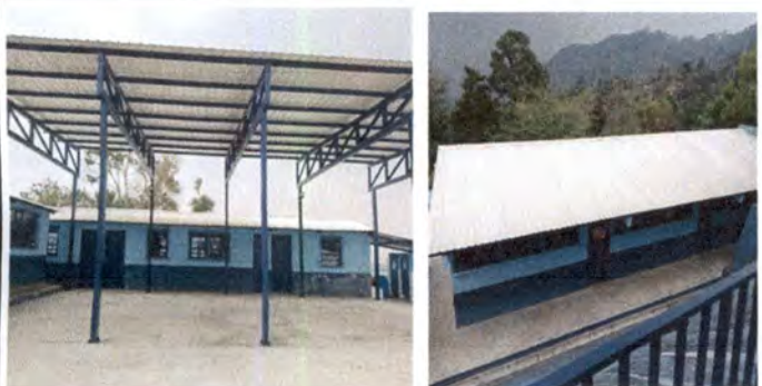
Foto 3: Trabajo de canales y bajadas de agua en techo de patio de Preprimaria y techo de módulo 2 de Primaria.
