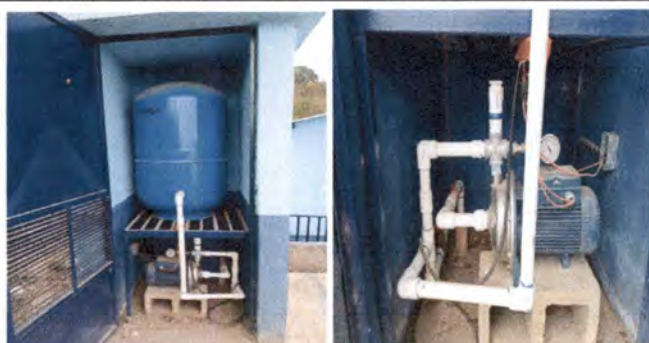
Foto 5: Reparación de bomba de agua.
