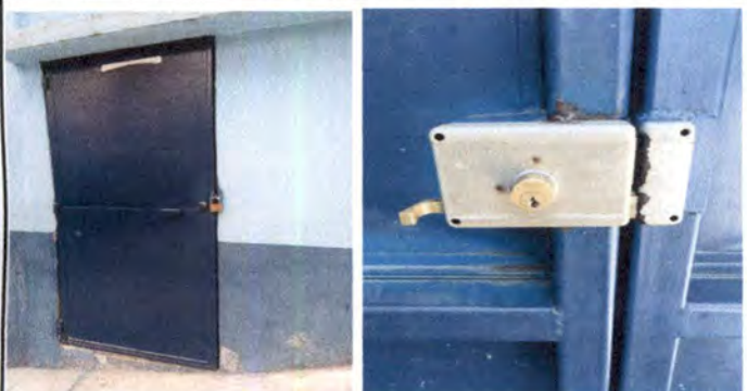
Foto 3: Sustitución de chapa del depósito de basura de la jornada matutina (se arruinó la chapa por eso se usa candado) y del portón( se juega la llave).
