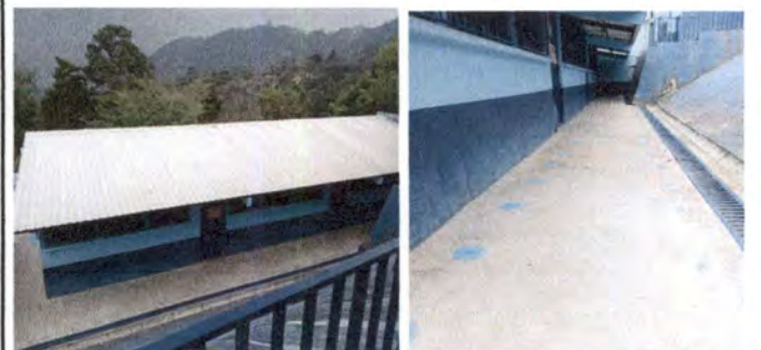
Foto 5: Sustitución de torta de concreto por piso de granito corredor de Primaria módulo 2.
