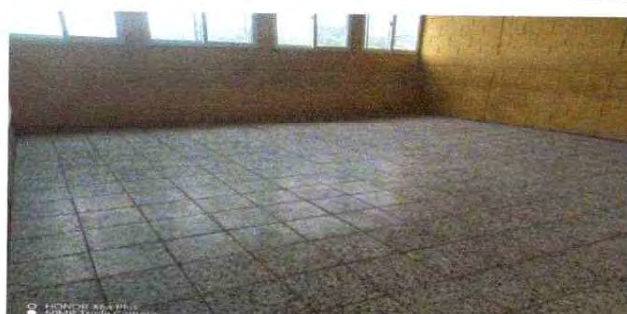
FOTO 5: Sumistro e instalacion de metros de piso granito de 30*30 en salon 1, salon 2 y salon 3 de segundo nivel y baño de varones
