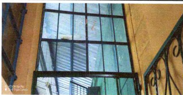
Foto 2: Sustitución de vidrio claro de 5 mm (0.525 por 0.765)
