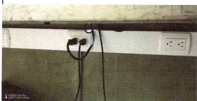
Foto 7: Sustrucción de ducto electrico+accesorios, ML mas cableado
