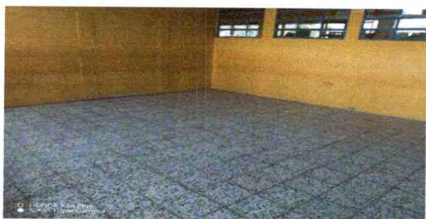
FOTO 5: Sumistro e instalacion de metros de piso granito de 30*30 en salon 1, salon 2 y salon 3 de segundo nivel y baño de varones
