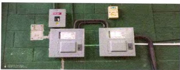
Foto 6: Sustitución de tablero y flipones ( un tablero 2 polos y uno de 8 polos)
