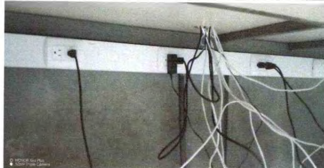
Foto 8: Instalacion de unidades fuerza (tomacorrientes) incluye cable electrico
