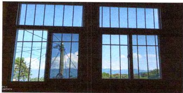
Foto1: Sustitución de ventana de metal por ventana de PVC con medidas de 1.16 metros de alto por 175 metros de ancho.
