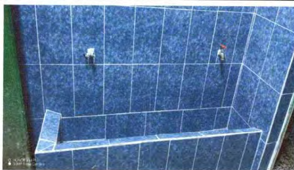
Foto 3: Suministro e instalación de metros de azulejo en baños, forado de lavamanos y cambios de azulejo a Urinal.
