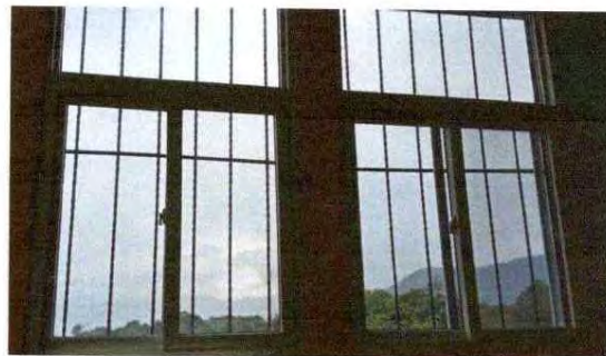
Foto1: Sustitución de ventana de metal por ventana de PVC con medidas de 1.16 metros de alto por 175 metros de ancho.
