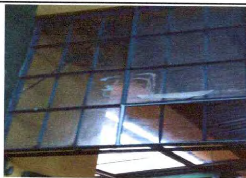
Foto 2: Sustitución de vidrio claro de 5 mm (0.525 por 0.765)
