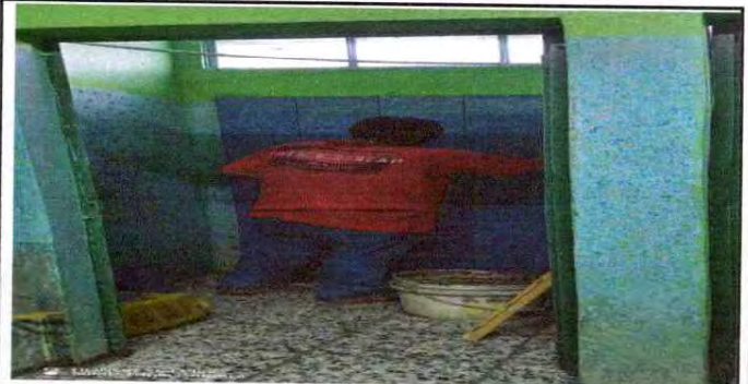
Foto 3: Suministro e instalación de metros de azulejo en baños, forado de lavamanos y cambios de azulejo a Urinal.
