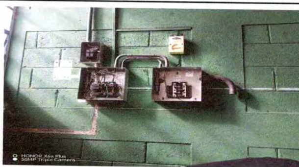
Foto 6: Sustitución de tablero y flipones ( un tablero 2 polos y uno de 8 polos)
