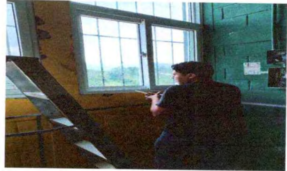
Foto1: Sustitución de ventana de metal por ventana de PVC con medidas de 1.16 metros de alto por 175 metros de ancho.
