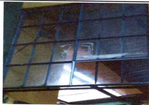
Foto 2: Sustitución de vidrio claro de 5 mm 0.525 por 0.255
