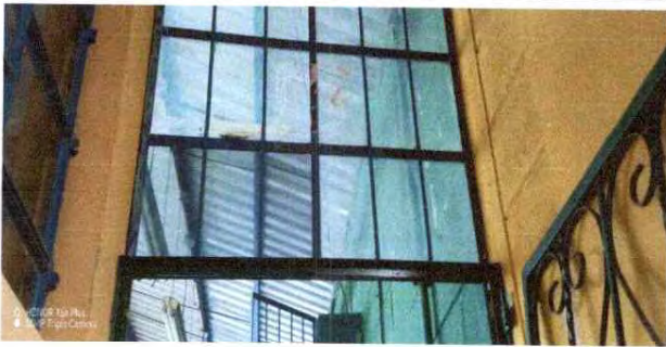
Foto 2: Sustitución de vidrio claro de 5 mm 0.525 por 0.255
