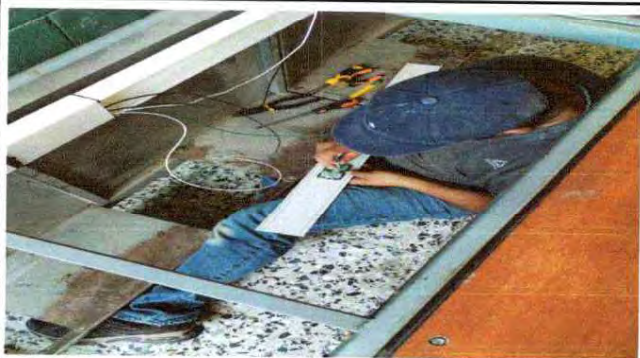
Foto 7: Sustitución de ducto electrico+accesorios, ML mas cableado
