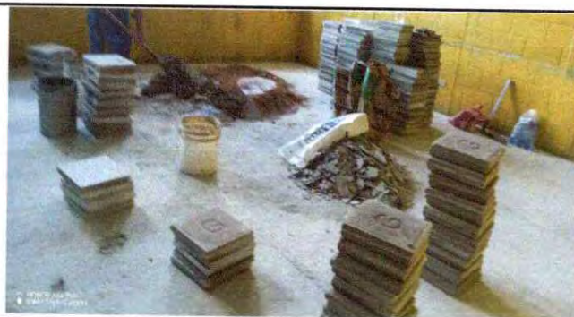
FOTO 5: Sumistro e instalación de metros de piso granito de 30*30 en salon 1, salon 2 y salon 3 de segundo nivel y baño de varones
