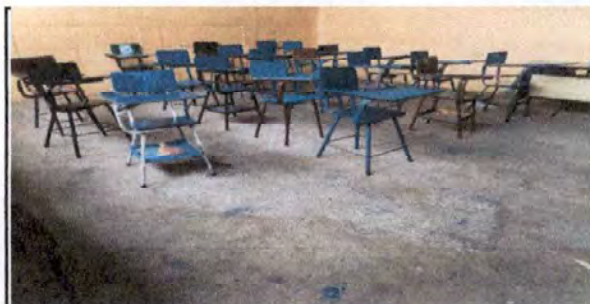
FOTO 5: Sustitución e instalación de cuadros de piso cuadrado de 30x30 en salas 1, salas 2 y salas 3 de segundo nivel y baño de varones
