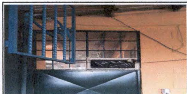
Foto 2: Sustitución de vidrio claro de 5 mm (525 por 1255
