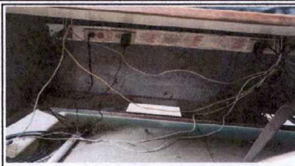
Foto 8: Instalacion de unidades fuerza (tomacorrientes) incluye cable eléctrico
