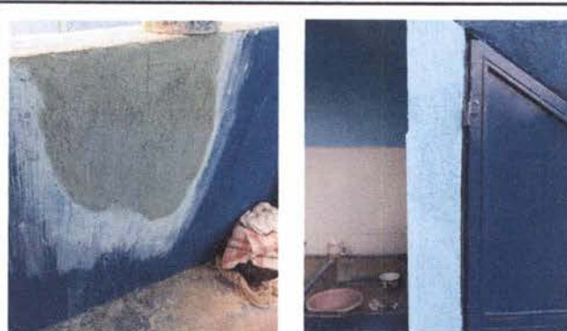
Foto 20: 21 REPARACION DE REPELLO Y CERNIDO DE PAREDES (CUANDO APLIQUE) Sellado de grietas y fisuras en muros
