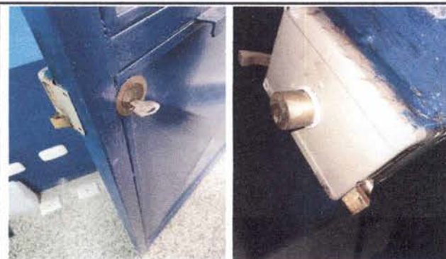
Foto 2: 4. PUERTA DE METAL Sustitución de Chapa
