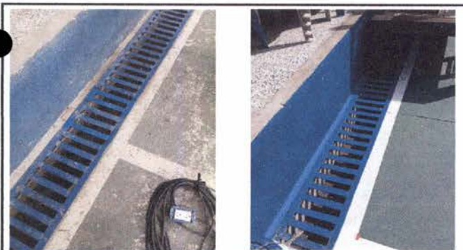
Foto 5: 8 CUNETETA DE CONCRETO Reparación de cuneta de concreto.
