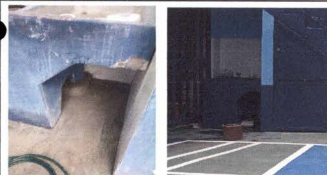
Foto 11: 14 REPARACION DE RED DE DRENAJE Y RED DE AGUA POTABLE Reparación de caja de registro
