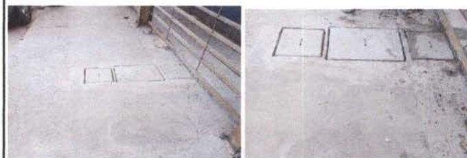
Foto 12: 14 REPARACION DE RED DE DRENAJE Y RED DE AGUA POTABLE Reparación de caja de contador.
