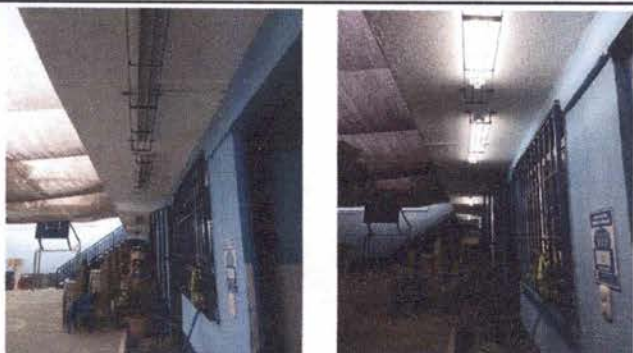
Foto 15: 17 REPARACION DE SISTEMA ELECTRICO Reparación de lamparas.
