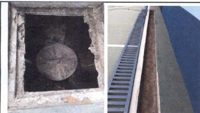
Foto 9: 14 REPARACION DE RED DE DRENAJE Y RED DE AGUA POTABLE Mantenimiento a caja de registro
