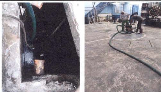
Foto 10: 14 REPARACION DE RED DE DRENAJE Y RED DE AGUA POTABLE Mantenimiento de fosa séptica
