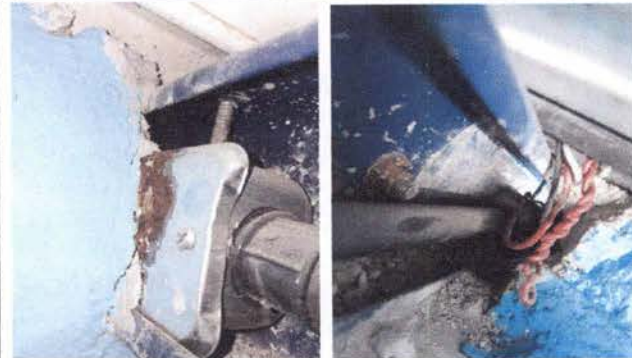
Foto 16: 17 REPARACION DE SISTEMA ELECTRICO Sustrucción de tomacorrientes
