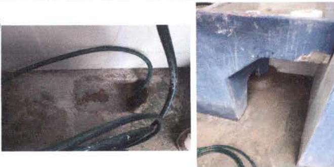
Foto 11: 14 REPARACION DE RED DE DRENAJE Y RED DE AGUA POTABLE Reparación de caja de registro
