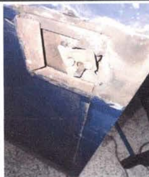
Foto 2: 4. PUERTA DE METAL Sustitución de Chapa
