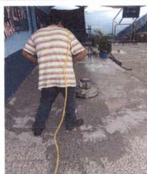
Foto 4: 6 PISO Mantenimiento de piso de granito (pulido y lustrado)
