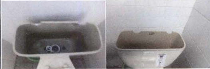
Foto 7: 10 SERVICIOS SANITARIOS Y SUS ACCESORIOS Sustitución de accesorios inodoro (contra llave, tubo de abasto y tanque).
