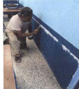
Foto 20: 21 REPARACION DE REPELLO Y CERNIDO DE PAREDES (CUANDO APLIQUE) Sellado de grietas y fisuras en muros
