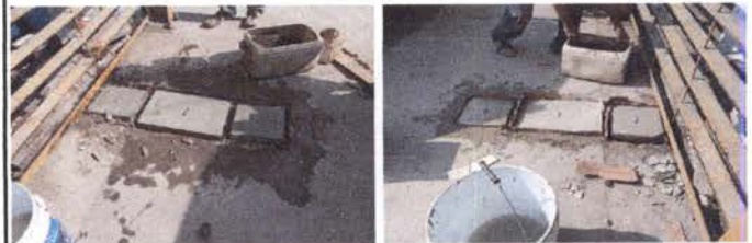
Foto 12: 14 REPARACION DE RED DE DRENAJE Y RED DE AGUA POTABLE Reparación de caja de contador.
