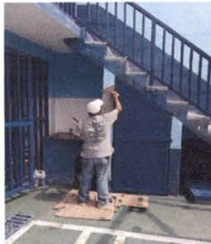
Foto 20: 21 REPARACION DE REPELLO Y CERNIDO DE PAREDES (CUANDO APLIQUE) Sellado de grietas y fisuras en muros
