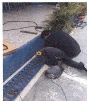
Foto 5: 8 CUNETA DE CONCRETO Reparación de cuneta de concreto.
