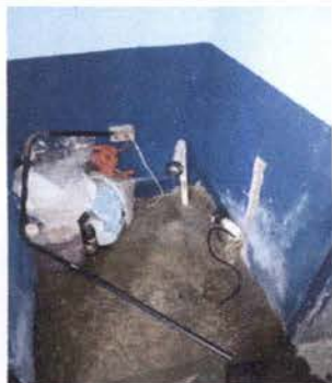
Foto 19: 18 REPARACION Y MANTENIMIENTO DE CISTERNAS / DEPÓSITOS DE AGUA Sustitución de bomba de agua.
