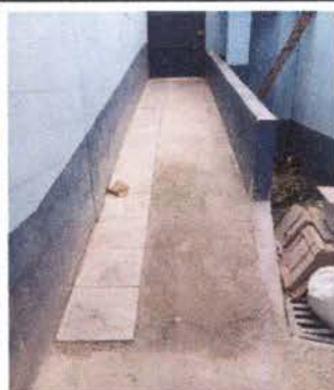
Foto 3: 6 PISO Reparación de piso de torta de concreto
