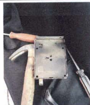
Foto 2: 4. PUERTA DE METAL Sustitución de Chapa
