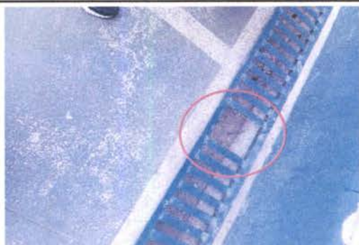
Foto 5: 8 CUNETA DE CONCRETO Reparación de cuneta de concreto.
