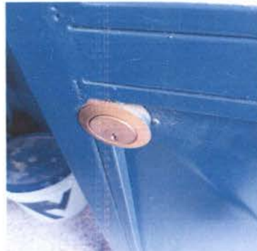
Foto 2: 4. PUERTA DE METAL Sustitución de Chapa
