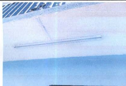
Foto 15: 17 REPARACION DE SISTEMA ELECTRICO Reparación de lamparas.
