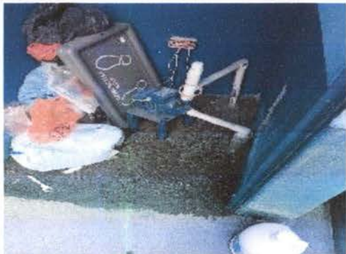
Foto 19: 18 REPARACION Y MANTENIMIENTO DE CISTERNAS / DEPÓSITOS DE AGUA Sustitución de bomba de agua.
