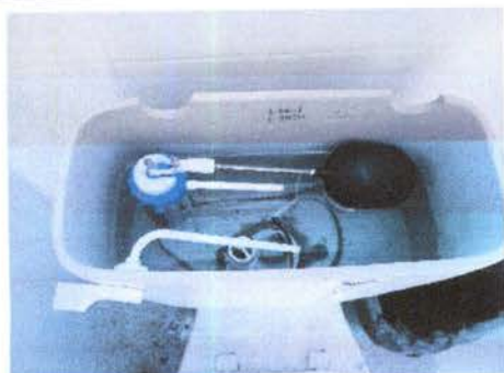
Foto 7: 10 SERVICIOS SANITARIOS Y SUS ACCESORIOS Sustrucción de accesorios inodoro (contra llave, tubo de abasto y tanque).
