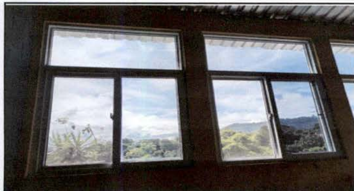
Foto 4: Sustrucción de ventana de metal por ventana de PVC con medidas de 181 metros de alto por 124 metros de ancho incluye cambio de vidrio de los salones 1, 2 y 3 del segundo nivel.
