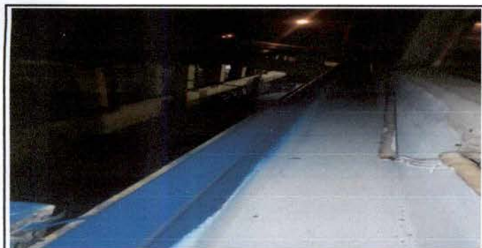
Foto 5: Impermeabilización de 22 mts cuadrados de canal de cemento, reparación de paredes laterales e inferior de 22 mts cuadrados de canal de cemento existente, eliminando grietas y fisuras con cernido fino con cemento y arena de río, en el pasillo de los salones 1, 2 y 3 del segundo nivel.
