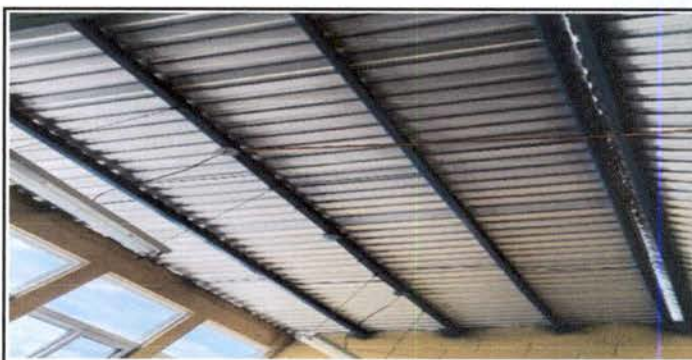
Foto 2: Desmontaje de lamina duralite existente, e instalacion de 190 mts cuadrados de lamina troquelada perfin E25, calibre 26 recubrimiento de aluminio y zinc, color natural aluminizado, fijadas a las costaneras mediante tornillos AURT APLUS(A+) 5/16x2" punta de broca con empaque de neopreno, con un minimo de 3 tornillos en cada lamina, en los salones 1, 2 y 3 del segundo nivel
