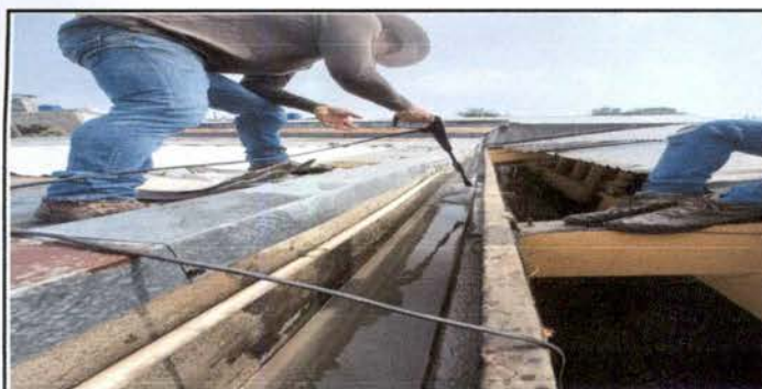
Foto 6: Impermeabilizacion de 22 mts cuadrados de canal de cemento, reparacion de paredes laterales e inferior de 22 mts cuadrados de canal de cemento existente, eliminando grietas y fisuras con corrida fina con cemento y arena de río, en el pasillo de los salones 1, 2 y 3 del segundo nivel.
