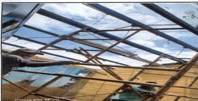
Foto 2: Desmontaje de lamina durablit existente, e instalacion de 680 mts cuadrados de lamina troquelada perfil EZ5, calibre 26 recubrimiento de aluminio y zinc, color natural aluminizado. fijadas a las costaneras mediante tornillos ALUT APUS(A+) 5/16x2" punta de broca con empaque de neopreno, con un mínimo de 3 tornillos en cada lamina, en los salones 1, 2 y 3 del segundo nivel
