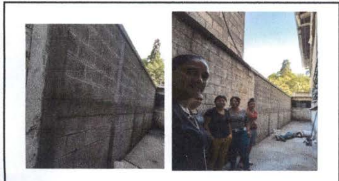
Foto 7: Pared atrás de la Escuela Presenta socavamiento en cimient y se esta rajando en varias áreas. . (colinda con barranco terreno de un vecino)
