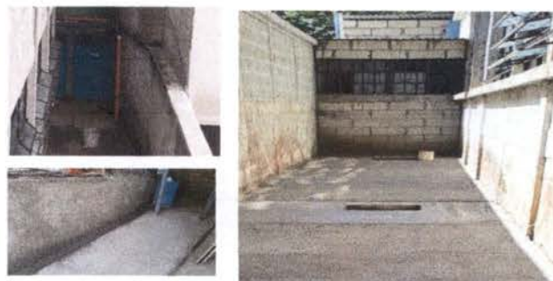
foto 6: Remoción y reubicación de 2 reposaderas, limpieza y extension de nueva linea de agua pluvial
