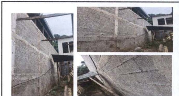
Foto 8: Pared atrás de la Escuela Presenta socavamiento en cimient y se esta rajando en varias áreas. . (colinda con barranco terreno de un vecino)
