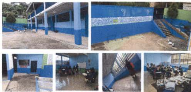
foto 4: Pintar muros interiores
