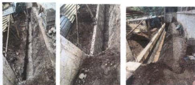
Foto 7: Pared atrás de la Escuela Presenta socavamiento en cimiento y se esta rajando en varias áreas. . (colinda con barranco terreno de un vecino)
