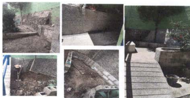
Foto 2: Reparar muro de contencion con piedra, electromalla y recubrimiento de concreto, Reinstalación y reparacion de banquetita para niños, Muro de el lado de enfrente se esta desboronando. Area de baños
