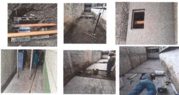
foto 6: Remoción y reubicación de 2 reposaderas, limpieza y extension de nueva linea de agua pluvial
