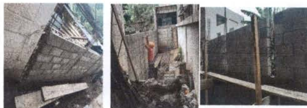
Foto 8: Pared atrás de la Escuela Presenta socavamiento en cimiento y se esta rajando en varias áreas. . (colinda con barranco terreno de un vecino)
