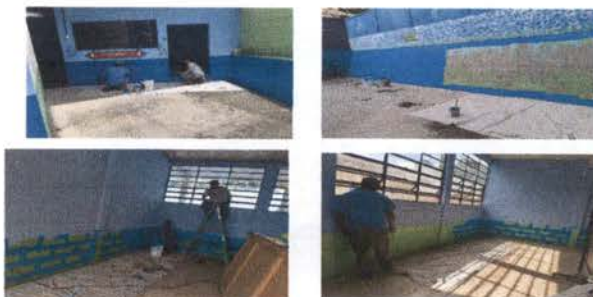
foto 4: Pintar muros interiores
