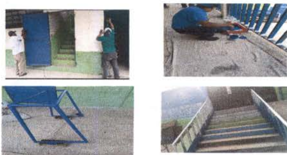
foto 5: mantenimiento a barandas de de metal, entrada principal y segundo nivel
