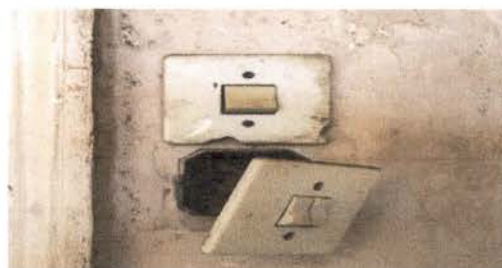
Foto 10: Cambio de Suich y tomacorrientes de luz , revisar plafoneras y cables en mal estado.
