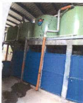
Foto 3: Entubar bajas de agua pluvias a cuneta y enviar a la salida asi evitar que quede sobre el piso.
