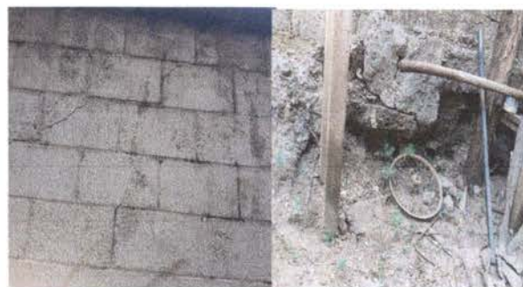
Foto 8: Pared atrás de la Escuela Presenta socavamiento en cimiento y se esta rajando en varias áreas. . (colinda con barranco terreno de un vecino)
