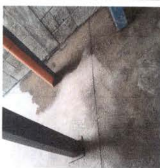
Foto 3: Entubar bajas de agua pluvias a cuneta y enviar a la salida asi evitar que quede sobre el piso.
