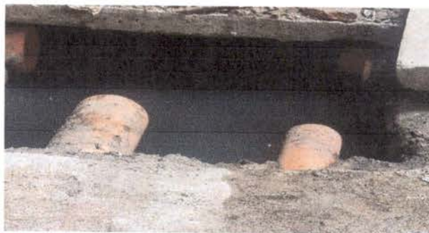
foto 6: Remoción y reubicación de 2 reposaderas, limpieza y extension de nueva línea de agua pluvial
