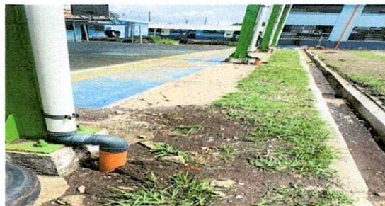
CANALETA Y CONEXIÓN DE BAJADA TERMINADA
