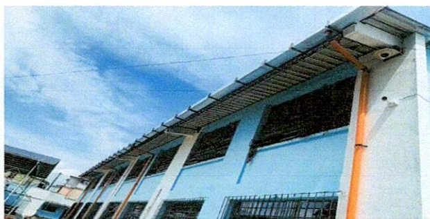
CANAL MODULO II TERMINADO
