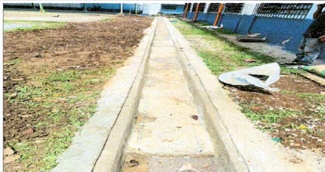
ANALETA MODULO II TERMINADO
