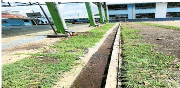
CANALETA LADO ESTE TERMINADO
