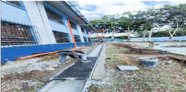
CANALETA MODULO II termiando
