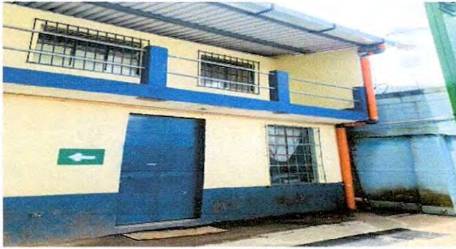
canal modulo 1 terminado
