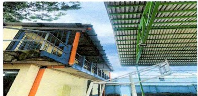
canal modulo 1 terminado
