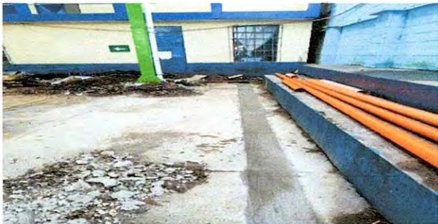
INSTALACION TUBERIA NUEVA
