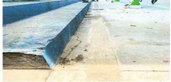
conexión tubería nueva terminado
