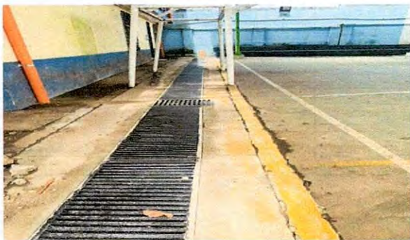
canaleta y rejillas lado sur, terminado
