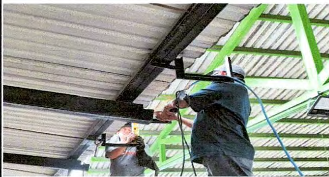
INSTALACION DE CANAL
