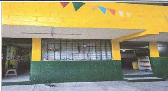
Foto: 1 pintura exterior
