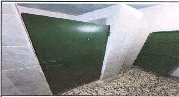
Foto: 1 colocacion de puerta
