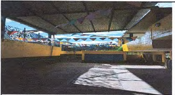
Foto: 1 pintura exterior
