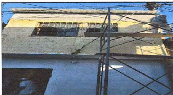
Foto: 1 repello de fachada de la entrada
