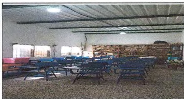
Foto: 1 cambio de techo
