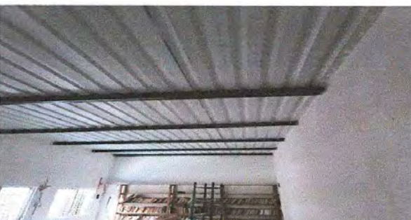
foto: 1 Elevacion de pared, mantenimiento a estructura portante, cambio de techo, repello de pared, pintura de interior.
