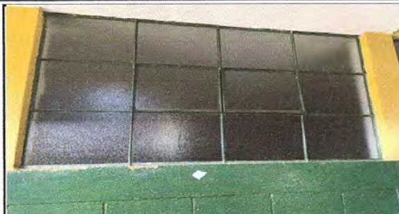
Foto: 1 Cambio de ventanas
