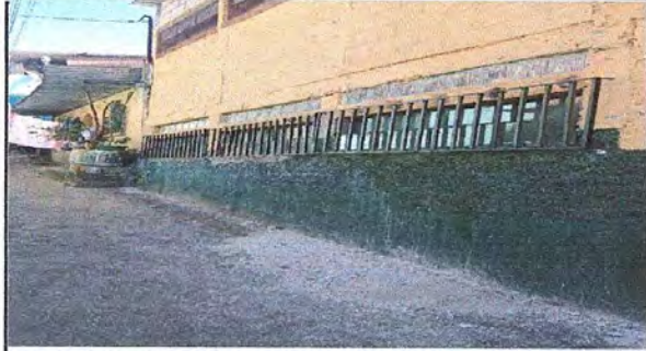
Foto: 1 Colocacion de 5 balcones
