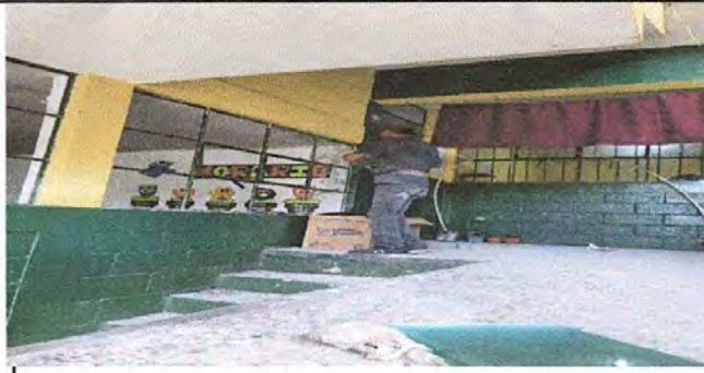
Foto: 1 Cambio de ventanas
