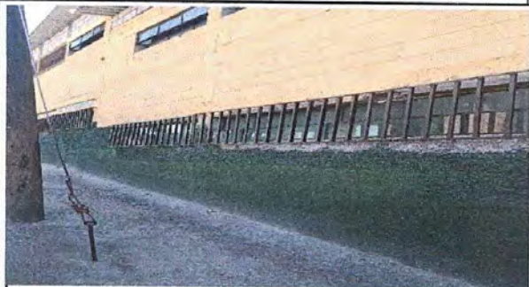
Foto: 1 Colocacion de 5 balcones
