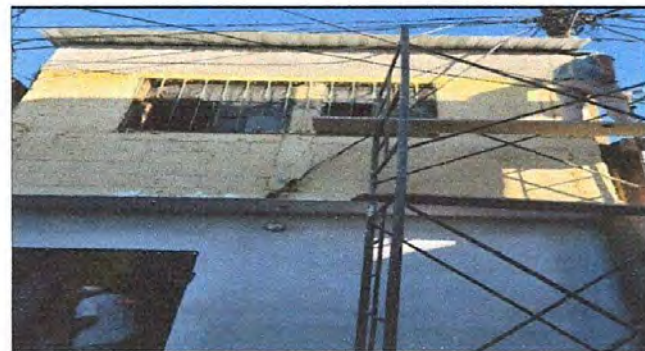
Foto: 1 repello de fachada de la entrada
