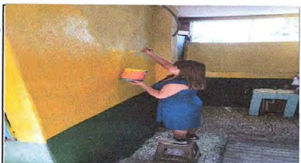
Foto: 1 pintura exterior
