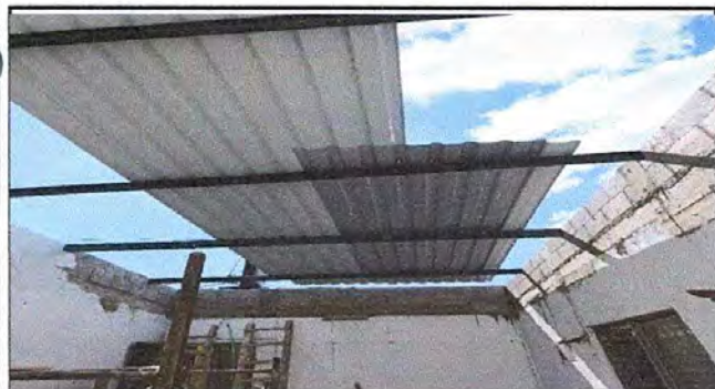
Foto: 1 cambio de techo
