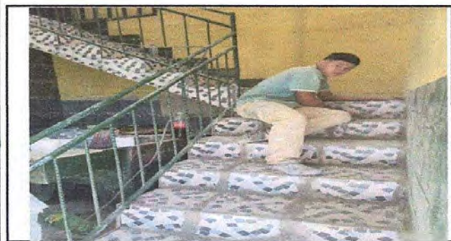
Foto: 1 reparacion de gradas
