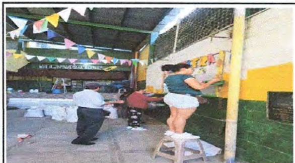
Foto: 1 pintura exterior
