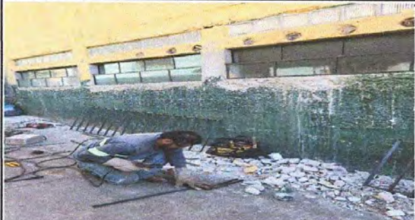
Foto: 1 Colocacion de 5 balcones
