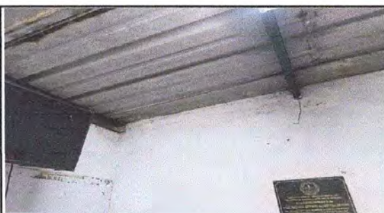
Foto: 1 cambio de techo
