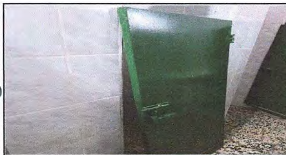
Foto: 1 colocacion de puerta
