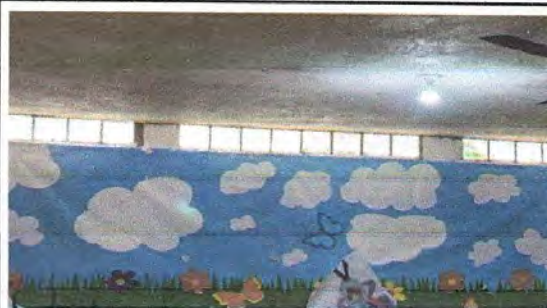
Foto: 1 Cambio de ventanas
