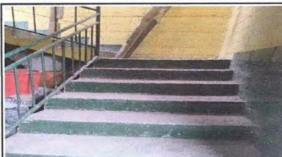
Foto: 1 reparacion de gradas
