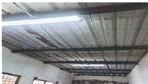
Foto: Mantenimiento de estructura
