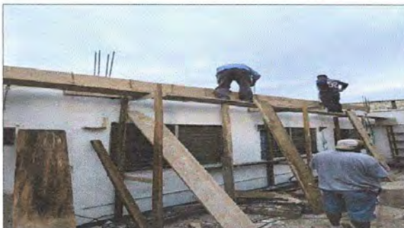
Foto: 1 elevacion de muro
