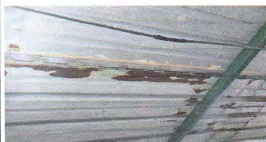
Foto: 2 Cambio de techo
