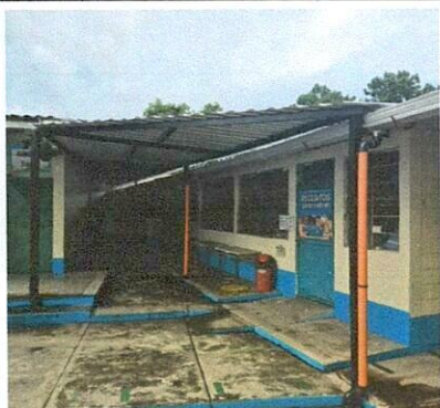
Foto 3: INSTALACIÓN DE NUEVA ESTRUCTURA METÁLICA
