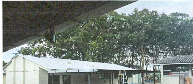
Foto 2: INSTALACIÓN TERMINADA DE LÁMINAS TERMOACUSTICAS PARTE FRONTAL
