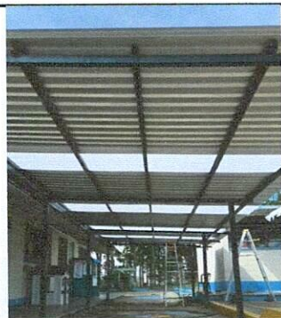
Foto 5: CAMBIO DE ESTRUCTURA METÁLICA Y REEMPLAZO DE LÁMINAS
