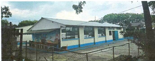
Foto 1: INSTALACIÓN TERMINADA DE LÁMINA TERMOACUSTICA PARTE TRASERA
